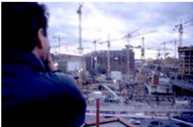
(3) Blick Richtung Daimler Benz Baustelle
