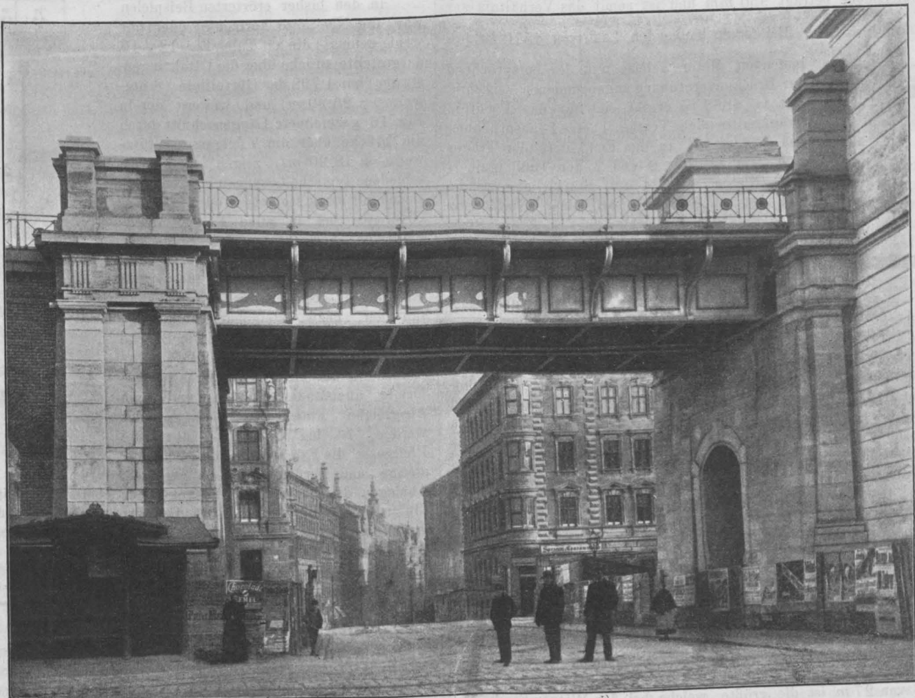
Brücke über die Gentzgasse im Zuge der Gürtellinie.
