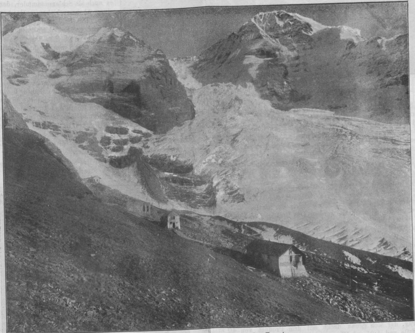
Übersicht des Bauplatzes vor dem großen Tunnel.
