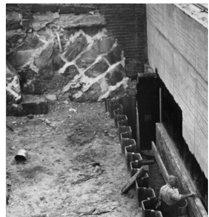
Abb. IV-43: Blick von Westen gegen wegen des Hochwassertollens gestutzte südliche Widerlager der Fleischbrücke, 1953/54. Foto R. Funk
