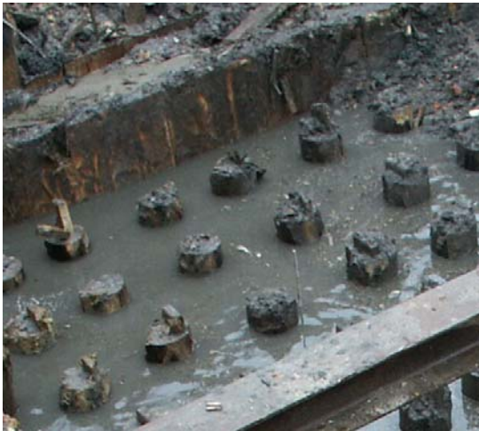
Abb. IV-41: Freigelegte Tragpfähle der Nedlitzer Brücke Sept. 2002. Foto C. Kaiser
