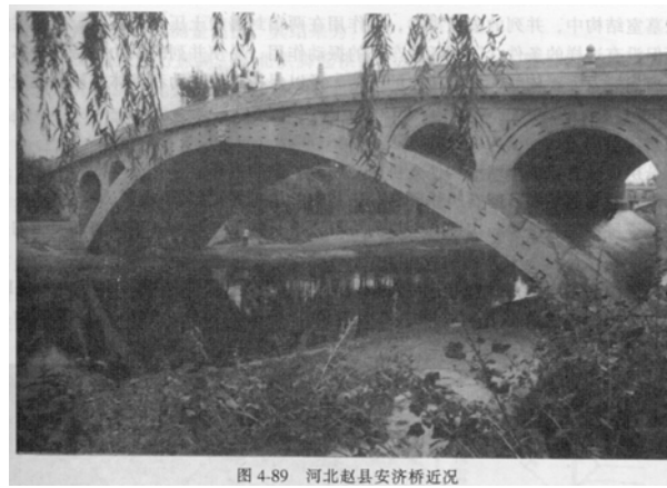
Abb. III-10: Zhaozhou Brücke, heutige Situation. Aus: Tang Huancheng (2000), Abb. 4-89
