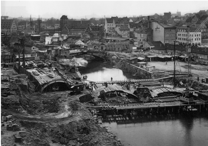
Abb. IV-62: Bauabschnitt I des Hochwasserentlastungsstollens ist fertig gestellt, Beginn des Bauabschnitts II, dem Neubau der Museumsbrücke. Blick von Osten. In Tiefbauamt Nürnberg
