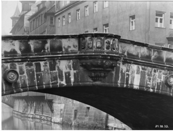
Abb. IV-74: Verwitterte Kanzeln der Fleischbrücke von Westen 31.10.1933. In Tiefbauamt Nürnberg (vgl. Bd. 3, Foto 16)
