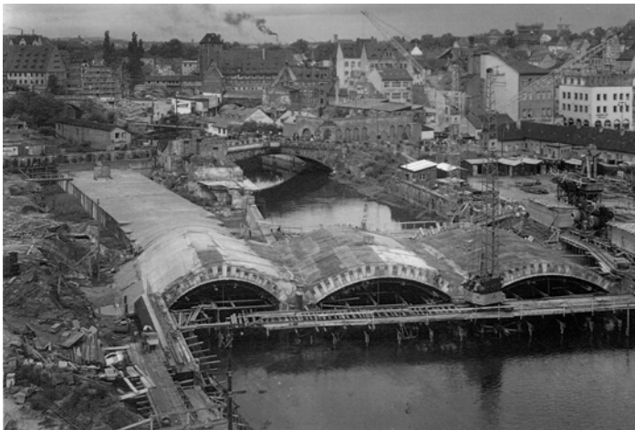
Abb. IV-63: Bau der Museumsbrücke mit dem dritten Bogen als Einlassbauwerk für den Hochwasserentlastungsstollen, Blick von Osten. In Tiefbauamt Nürnberg
