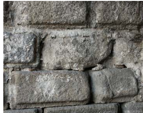
Abb. III-8: Puente de Segovia, Untersicht mit eingelegten Kieselsteinen als Abstandshalter. Januar 2003. Foto C. Kaiser
