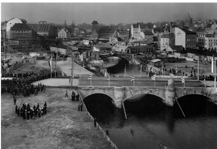
Abb. IV-64: Fertigstellung des II. Bauabschnittes. In Tiefbauamt Nürnberg
