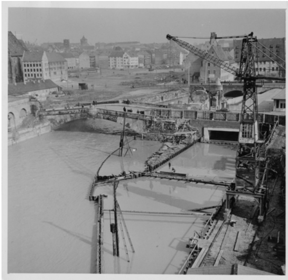
Abb. IV-65: Baustelle des III. Bauabschnitts, dem Auslaufbauwerk, bei Hochwasser unter Wasser, Blick von Westen. In Tiefbauamt Nürnberg (vgl. Bd. 3, Foto 39)
