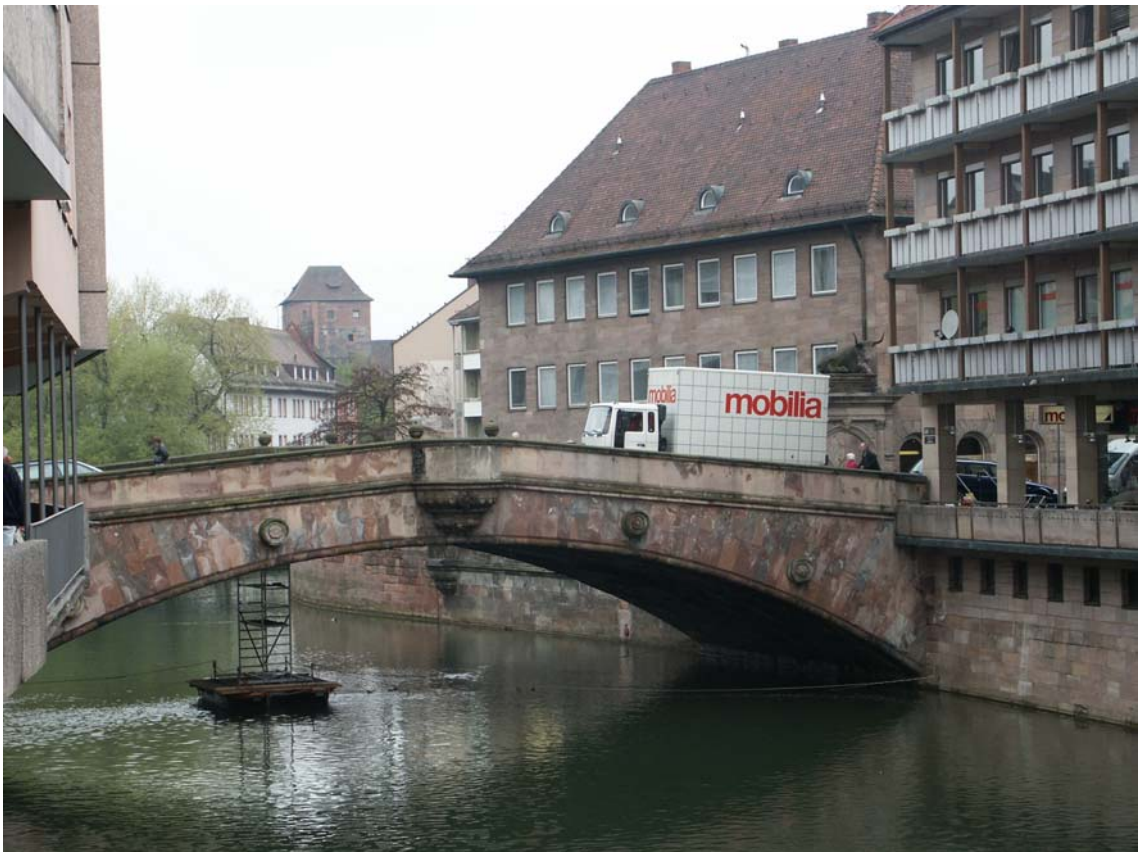
Abb. IV-60: Fleischbrücke von Osten mit Ponton zur Aufnahme der Brückenuntersicht, 19.4.2004. Foto c. Kaiser
