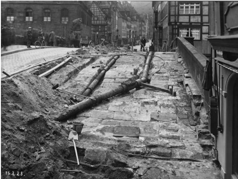
Abb. IV-61: Versorgungsleitungen in der Fleischbrücke 1928. In Tiefbauamt Nürnberg (vgl. Bd. 3, Foto 14)
