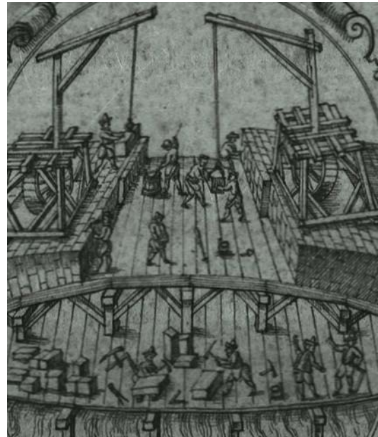
Abb. IV-93: Errichtung des Bogens der Fleischbrücke 1598, Ausschnitt aus der Zeichnung zum Petzold-Pokal, undatiert. Im Nachlass W. v. Stromer (vgl. Bd. 3, Grafik 20)
