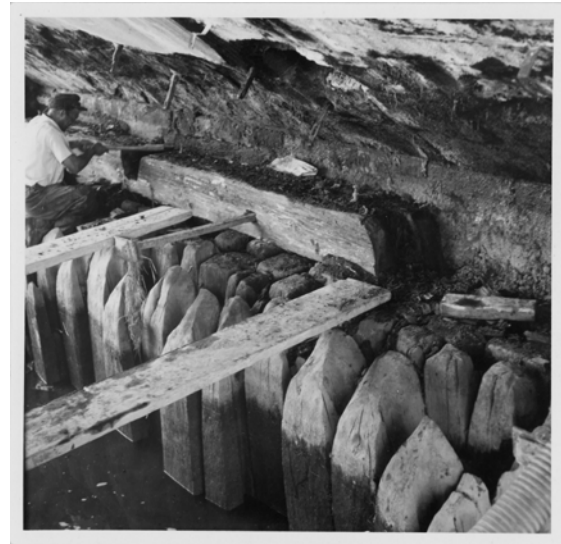
Abb. IV-38: Fleischbrücke, Südwiderlager, Pfahlgründung mit Schwelle an der Pegnitz, 6.6.1956. Foto R. Funk (vgl. Bd. 3, Foto 42)
