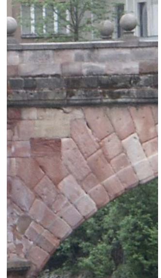
Abb. I-20: Detail Steinschnitt aus Abb. I-19
