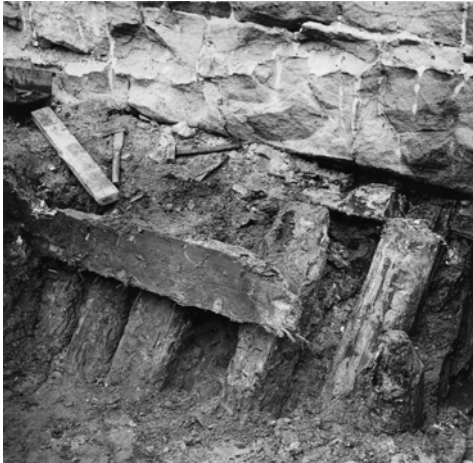
Abb. IV-39: Schrägpfähle der Fleischbrücke am Süd widerlager, 1953/54. Foto R. Funk (vgl. Bd. 3, Foto 33)
