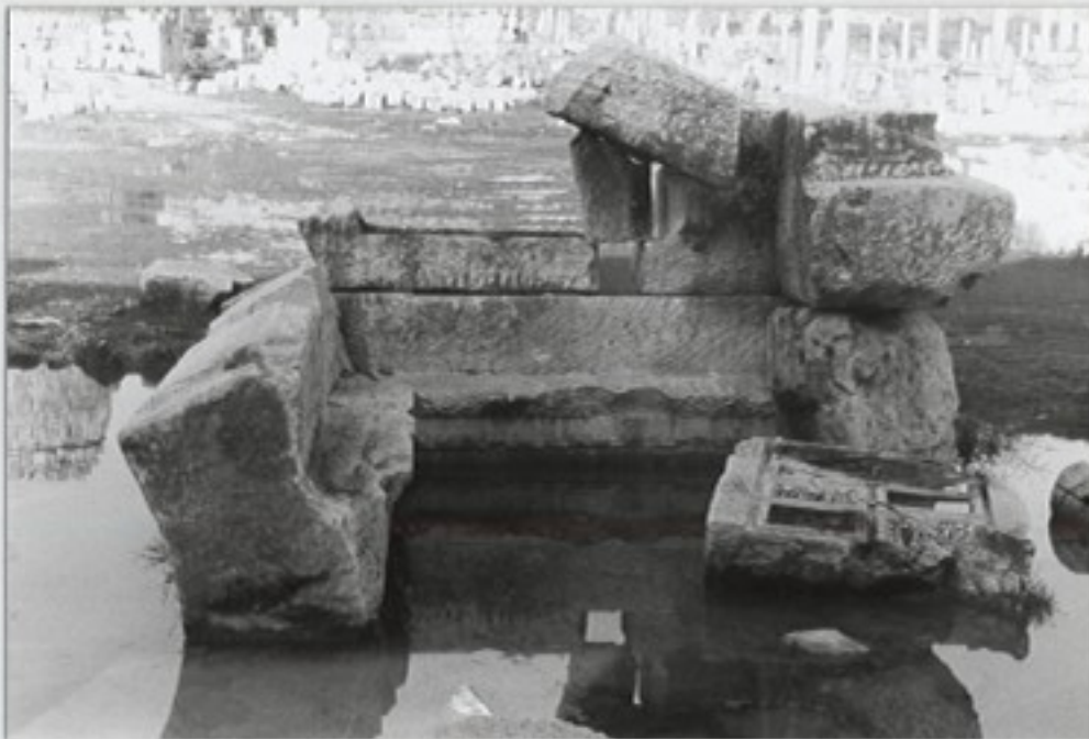
2. Kassettenkonstruktion des spätantiken Torbaues (C 2) in Perge
