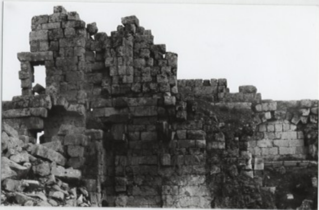
1. In situ erhaltene Reste des zweiten Geschosses
