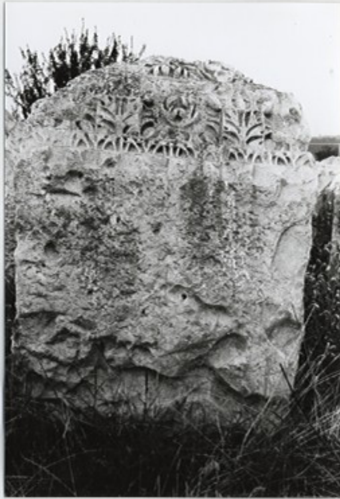
1 Attikagesims L.1-A.67.90 vom zweiten Geschoß
