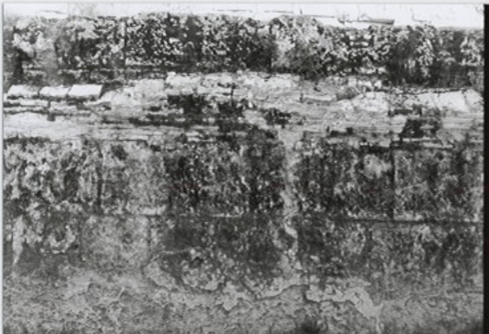
2 Mauerwerk des Unterbaues der scaenae frons
