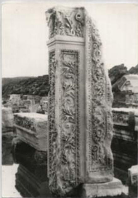
1 Nordseite des Pfeilers LVII.30-A.86.16 vom dritten Geschoß
