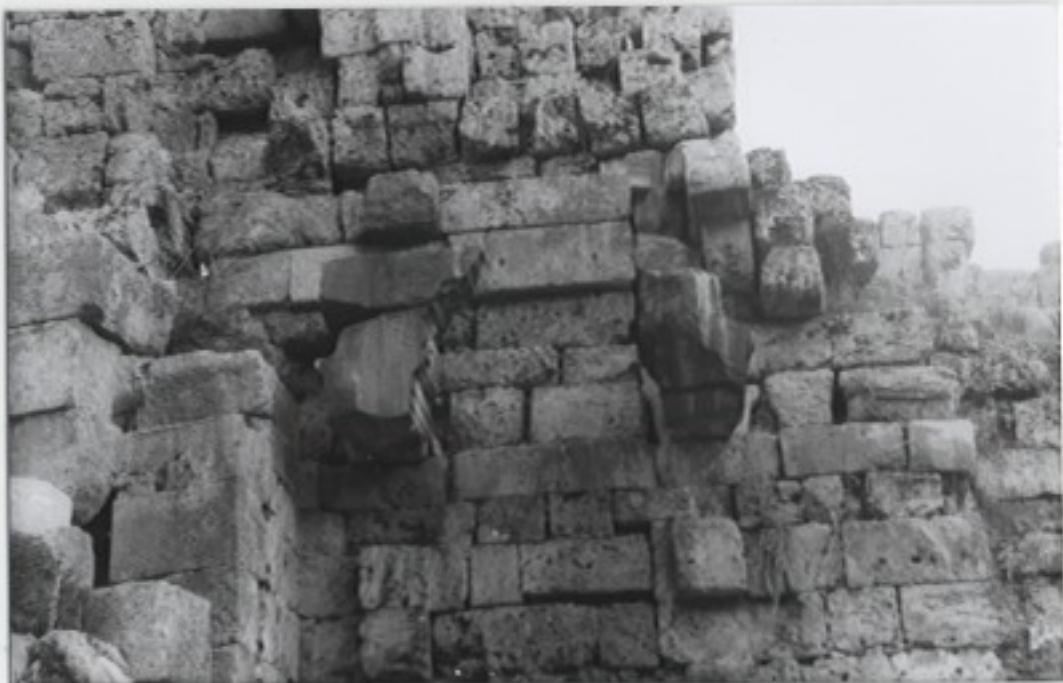
2 Gebälk in situ im ersten Geschoß
