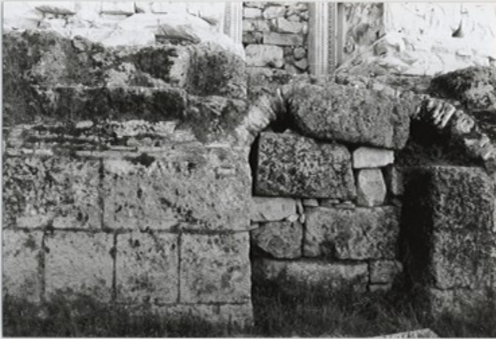
1 Gewölbe über dem nördlichen Seiteneingang des Unterbaues
