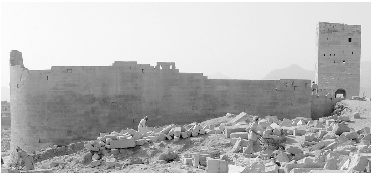
b. Nordansicht der gekurvten Umfassungsmauer, außen
