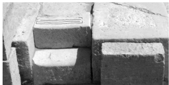
e. eingearbeitete Rillen auf Treppenstufe und grob angeraute Standfläche auf Eckplinthe für Pfeiler
