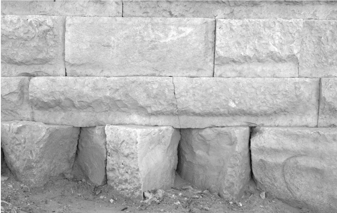
a. Unterseitig ausgeklintete Quader über den Fundamentblöcken als Ausgleichsschicht für das aufgehende Mauerwerk
