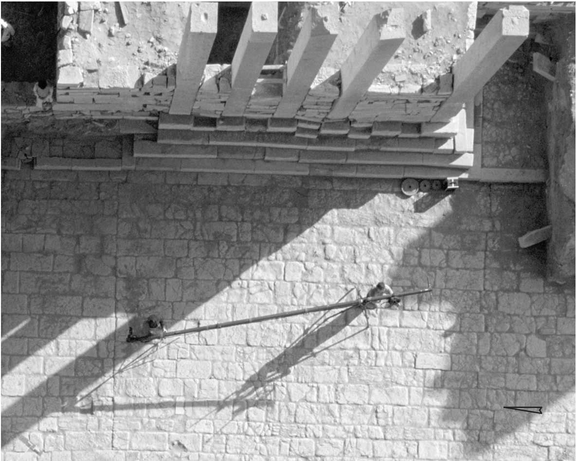
b. Aufsicht Vorhof mit Baufugen
