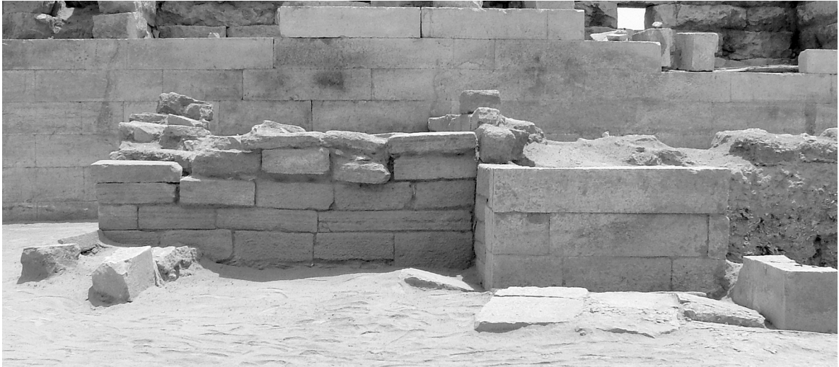
a. Nordansicht des östlichen spätantiken Anbaus, außen
