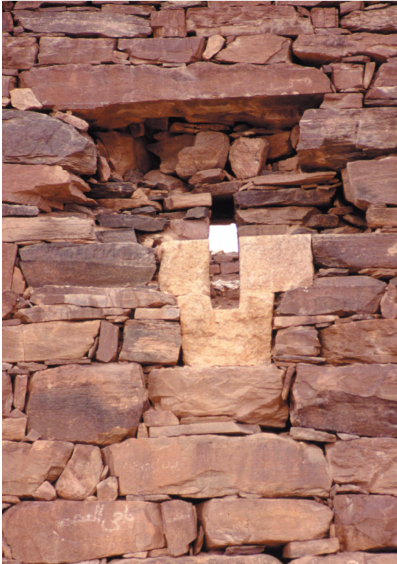
a. Samsara, Wasserspeier aus drei Kalksteinquadern bestehend am Tempel des Waddum du-Masma'im
