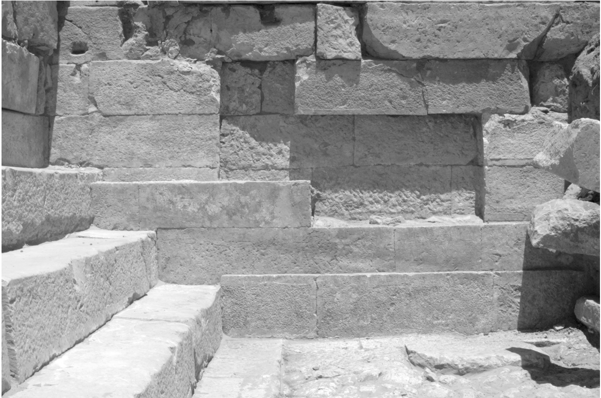
a. Westansicht der Inneren Temenosmauer, außen, Blick auf Nische
