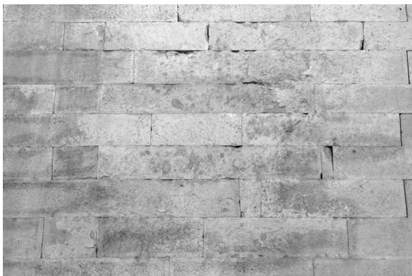
b. Flechtenbildung auf der Oberfläche der Kalksteinquader
