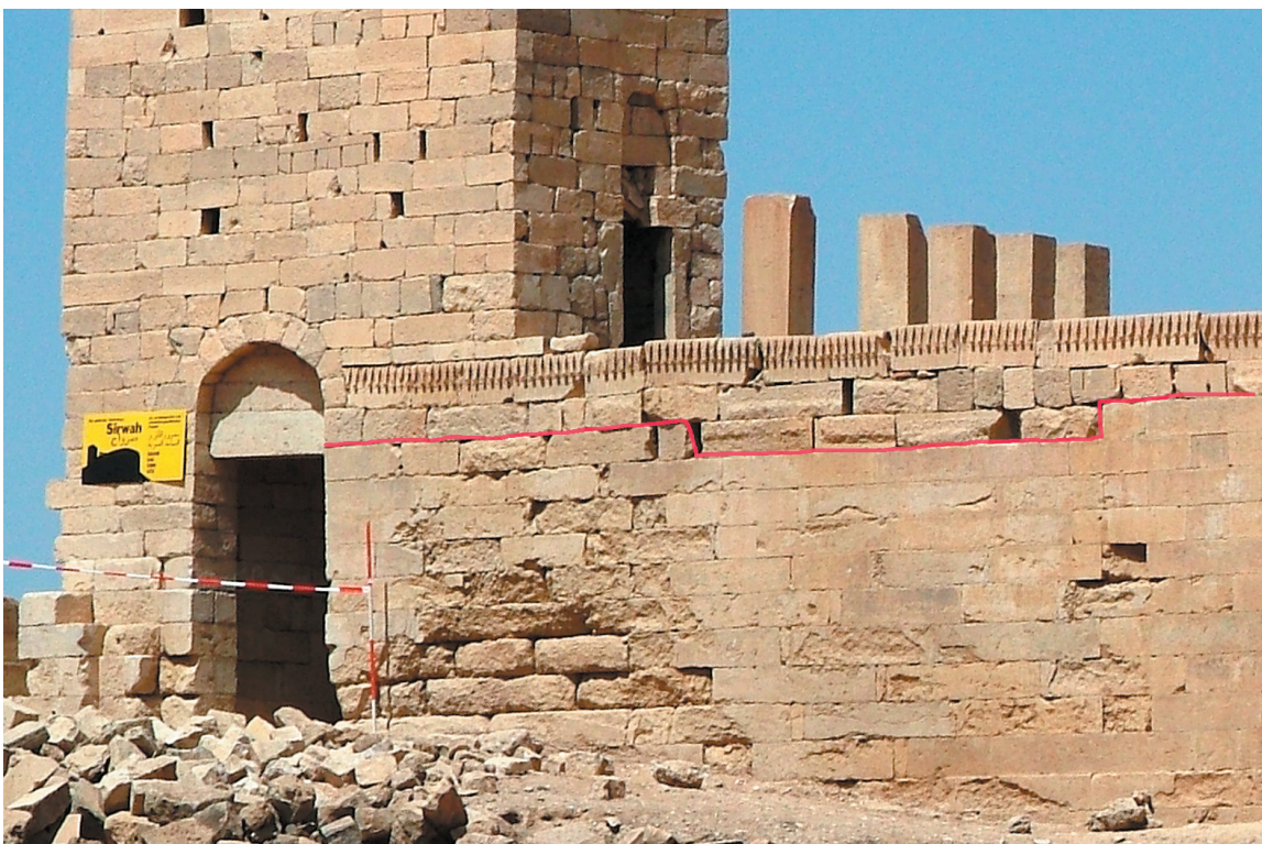
b. Südfassade der gekurvten Umfassungsmauer mit als Spolien verbaute Steinbockfriese
