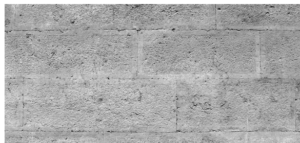
e. Exakter Fugenschluss
