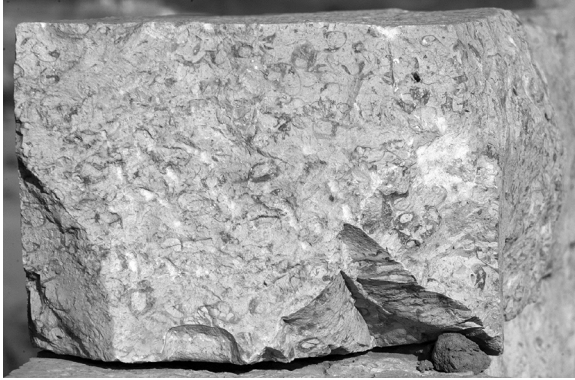
a. Hebellöcher am Unterlager eines Kalksteinquaders der gekurvten Umfassungsmauer
