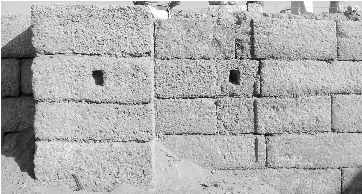
b. nördliche Torlaibung des Nordeingangs Z3
