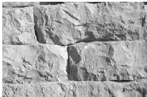
c. Bearbeitung der Lagerflächen durch 'Pfanne' und 'Zapfen'
