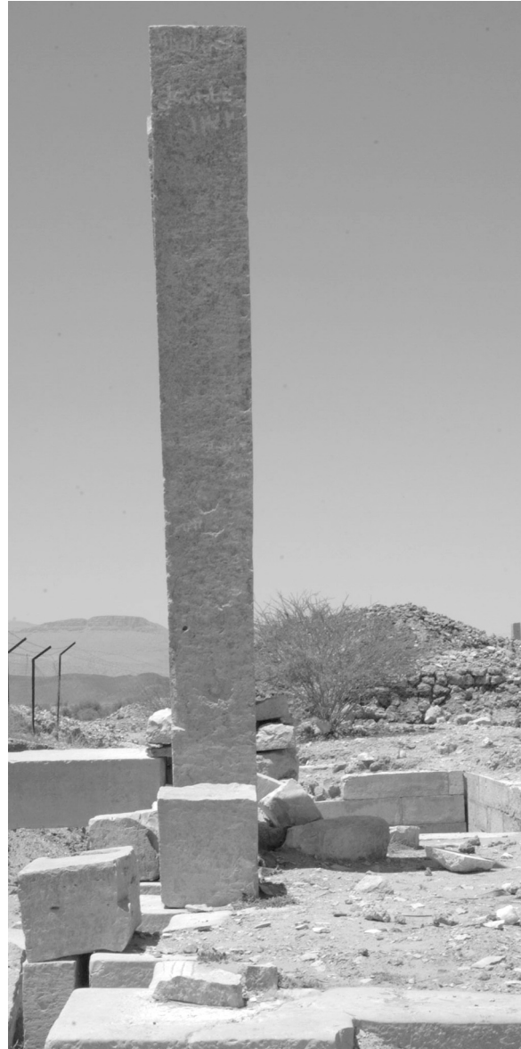
b. Südansicht des Äußeren Propylons
