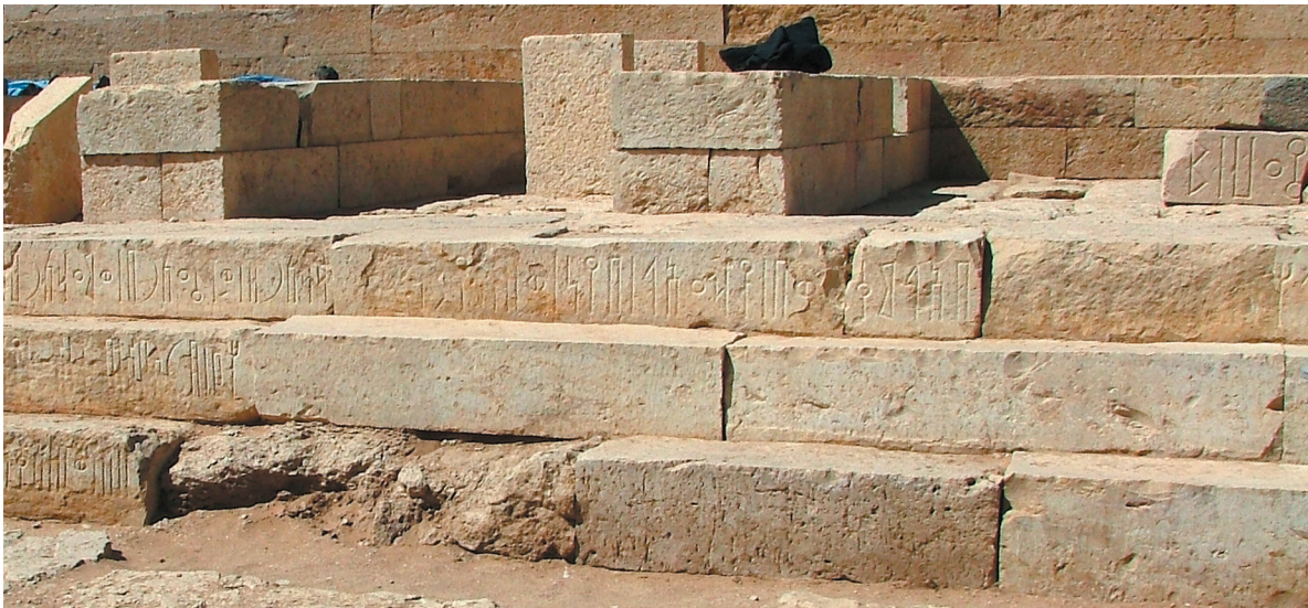
c. Stark zerstörte Stufe aus Travertin, die wie die rechts daneben schon in antiker Zeit ausgewechselt wurde
