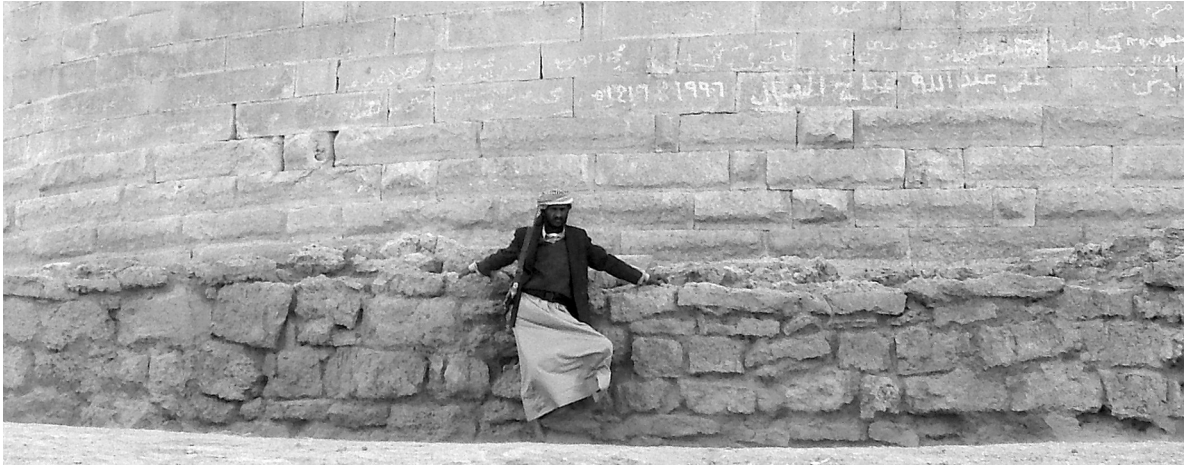
a. Südostansicht der 'Parallelen Bruchsteinmauer'
