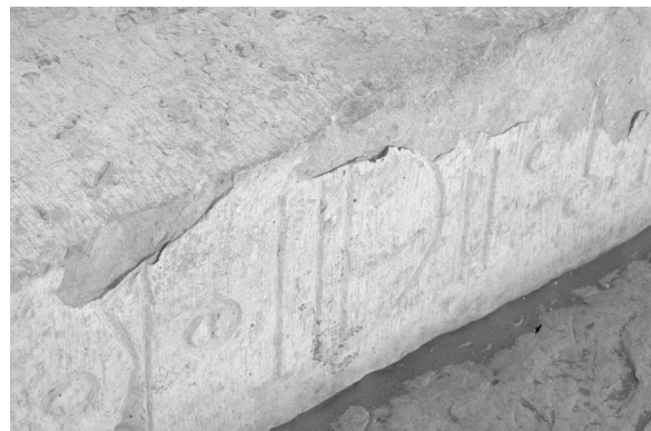
e. Abschalen des Materials entlang der mit Inschriften versehenen Stirn der Treppenstufen der Terrassenanlage
