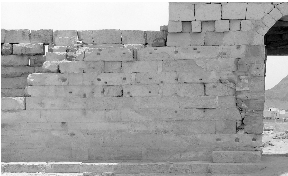
c. Nordansicht der gekurvten Umfassungsmauer am Südeingang (Z2), innen
