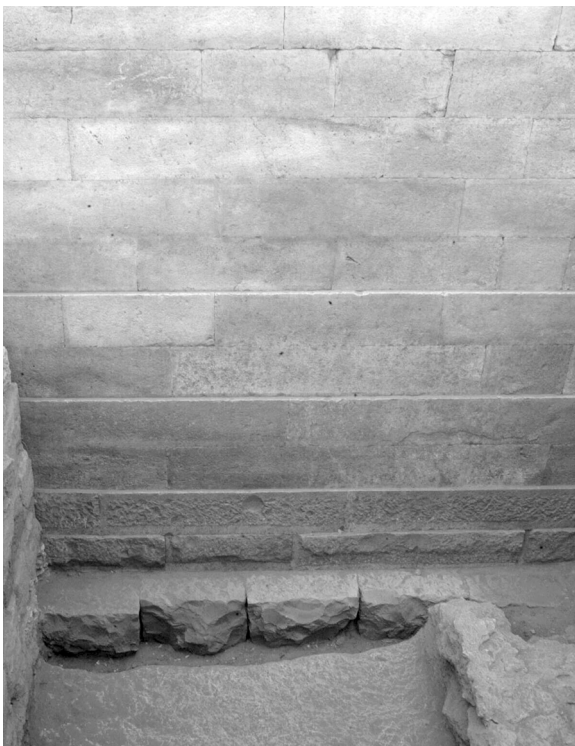
b. Fundamentblöcke der gekurvten Umfassungsmauer auf der Nordseite mit Fundamentgraben
