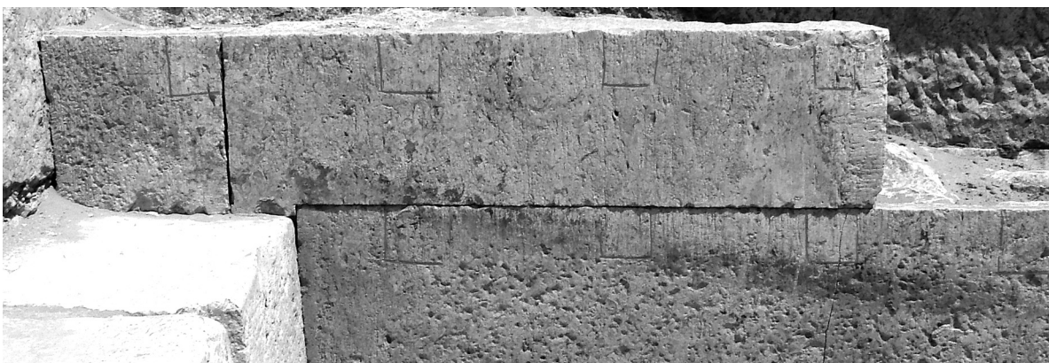
c. Westansicht der Inneren Temenosmauer südlich des Inneren Propylons
