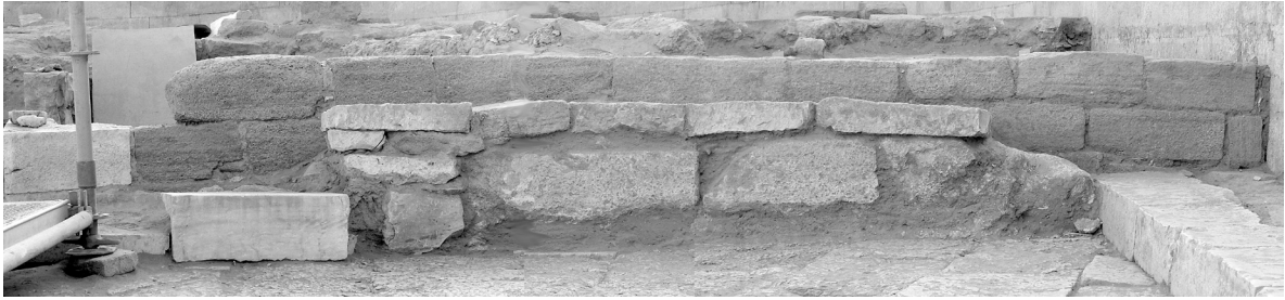
a. Westfassade des Knochendepots mit Lapillibreccequadern, im Vordergrund spätantike Spolienmauer, Stufeneinbau rechts im Bild
