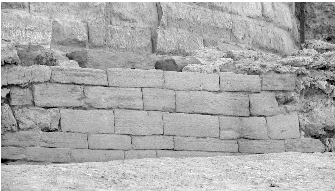
a. Ausschnitt der Parallelen Bruchsteinmauer (Ansicht von Osten) mit Lapillibrecciequadern südlich der N-W-Krümmung
