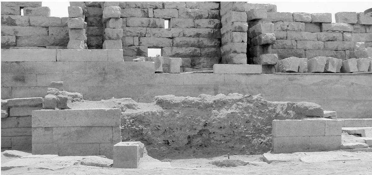
b. Nordfassade des Knochendepots mit Kalksteinquadern
