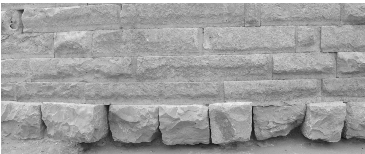
c. Fundamentblöcke der gekurvten Umfassungsmauer an der Ostseite
