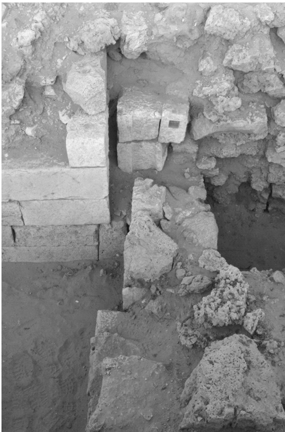
b. Blick nach Osten, Türöffnung mit eingearbeiteter Nut an der Südecke der südlich angebauten Mauer
