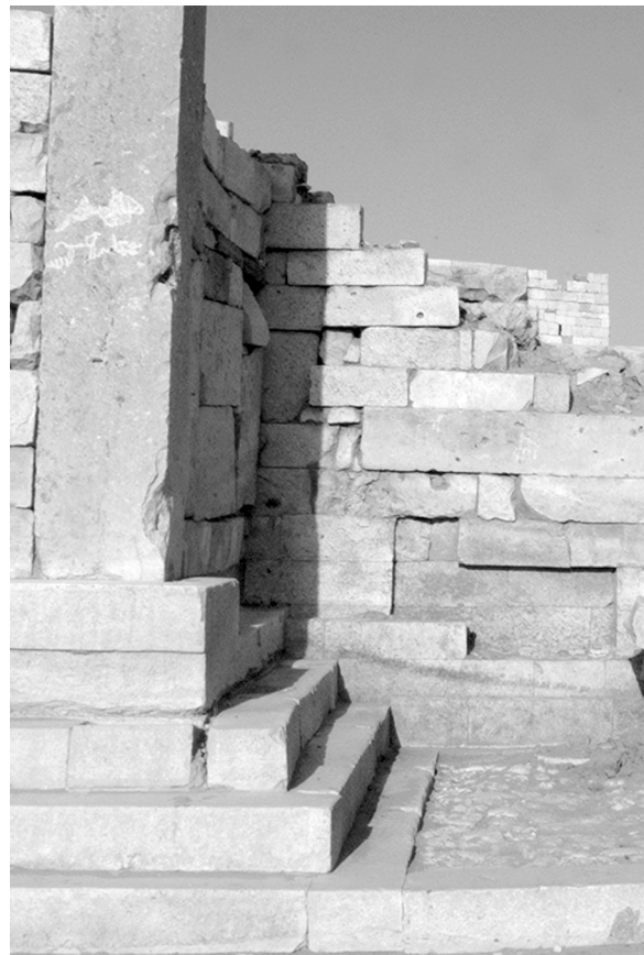
c. Westfassade des Inneren Propylons und der anschließenden Inneren Temenosmauer mit Nische
