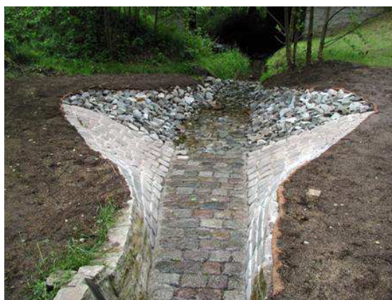
(c) Raupflaster im Vordergrund und Steinschüttung im Hintergrund aus Wasserbausteinen LMB 10/60 am Poisenbach in Freital, Sachsen. Die Blickrichtung ist stromabwärts gerichtet.
