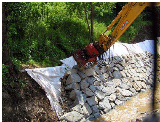
(b) Setzpack aus Wasserbausteinen LMB 40/200 auf Geotextil am Pöbelbach in Schmiedeberg, Sachsen. Die Blickrichtung ist stromaufwärts gerichtet.
