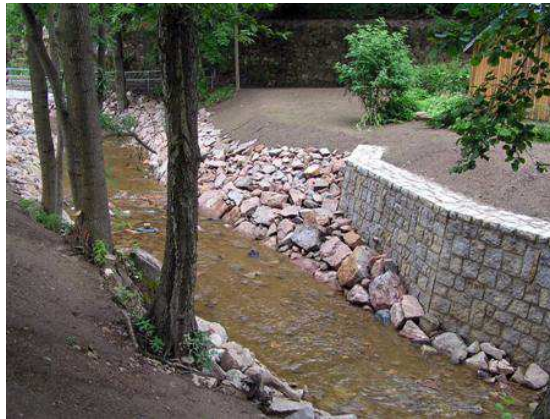
(a) Im Hintergrund Steinschüttung aus Wasserbausteinen LMB 10/60 am Pöbelbach in Schmiedeberg, Sachsen. Die Blickrichtung ist stromabwärts gerichtet.
