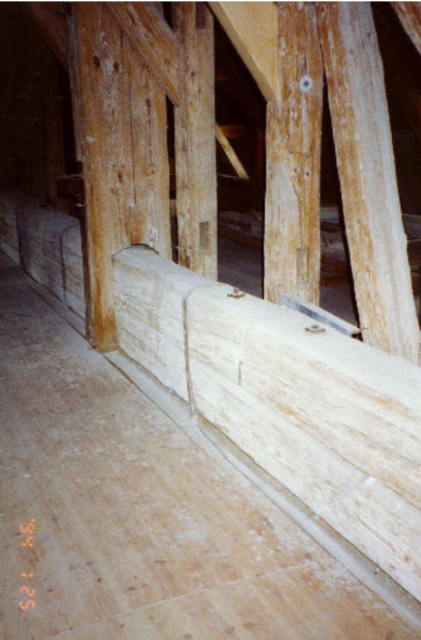
Foto 2 Lutherhalle Wittenberg – Teilansicht der Hängekonstruktion zur Aufnahme der Deckenlasten
