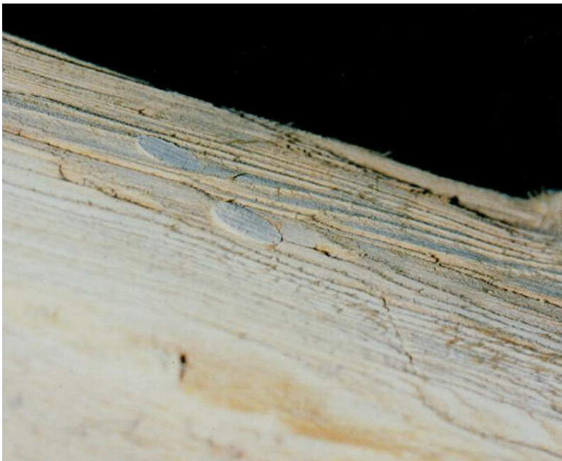
Foto 9 Stadthalle Zerbst (Westseite) – Beprobung an einer Strebe in der Binderebene (a). Fortschreiten der Mazeration ein Jahr nach der Beprobung (b), (c).
