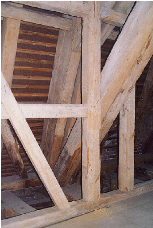
Foto 6 Stadthalle Zerbst (Südseite) – Beprobung an einer Stütze der Stuhlkonstruktion (a). Korrodierter Nagel im Bereich der Probenentnahme (b).
