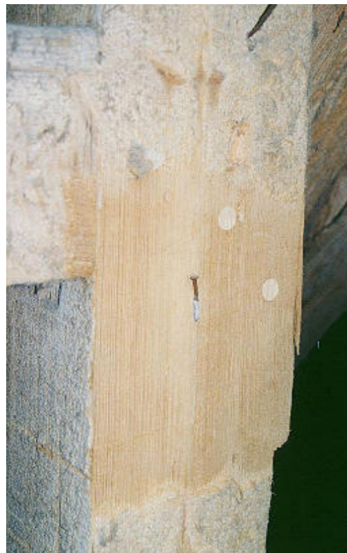
Foto 6 Stadthalle Zerbst (Südseite) – Beprobung an einer Stütze der Stuhlkonstruktion (a). Korrodierter Nagel im Bereich der Probenentnahme (b).
