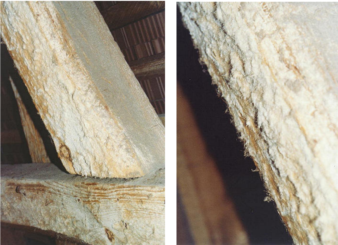
Bild 0.1 Korrosionserscheinungen (Zerfaserung der Oberfläche und Salzausblühungen) an Hölzern des Dachstuhles der Stadthalle Zerbst
