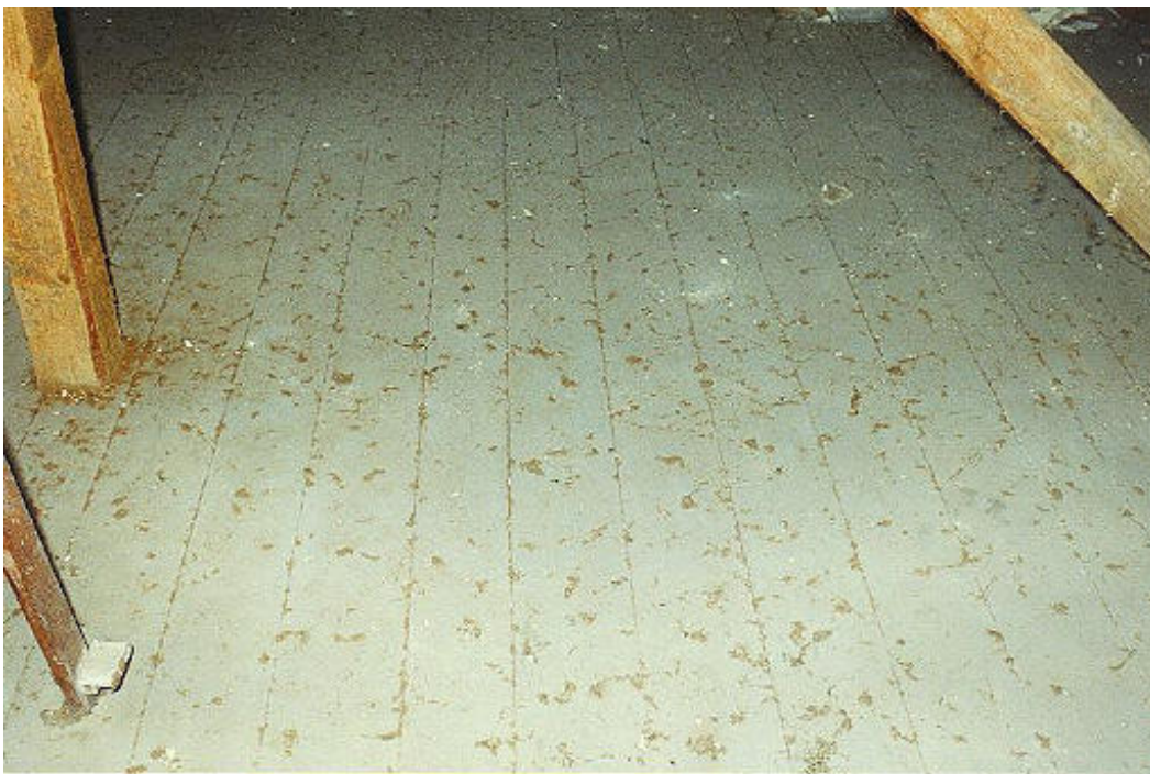
Foto 11 Herabgefallene Faserbündel
