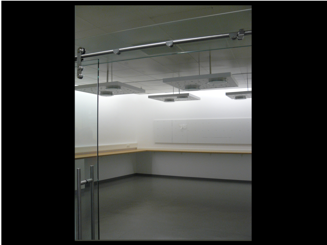
Einbau von Glasschiebetüren an vielen Durchgängen im Haus
