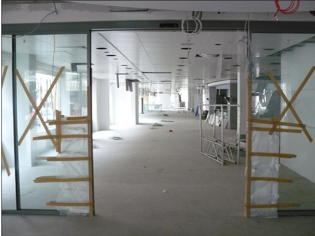
Einbau einer zweiten automat. Schiebetür am Haupteingang als Windfang u. für die 24-Std.-Rückgabe
