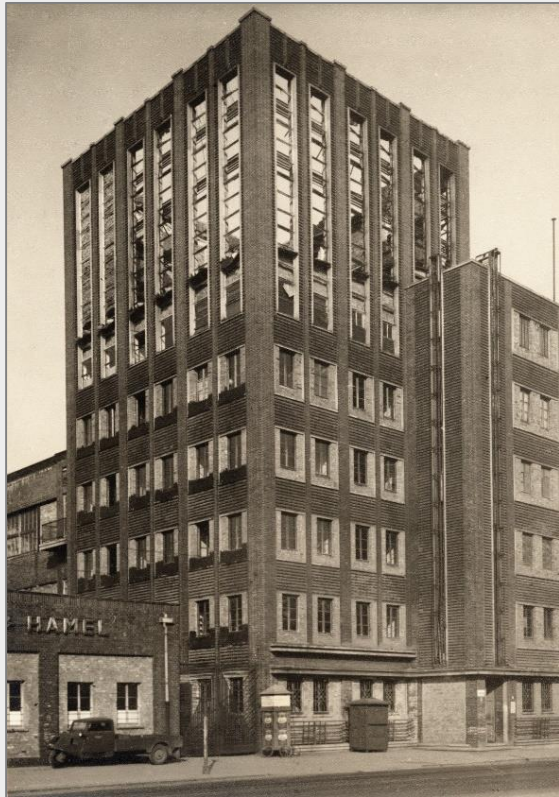
StB 1950: oben noch zerstört, unten wieder in Betrieb
