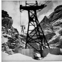
459. Erhabene österreichische Schmelzschleife von Eberwald. Die 3062 m lange Bahn überwindet 1589 m Höhenunterschied. Die 48 mm starke Exploitei hat über 9 auf den 1000 m hohe Turm. Bergstation 2805 m (Zugspitzhöhe 2664 m).
