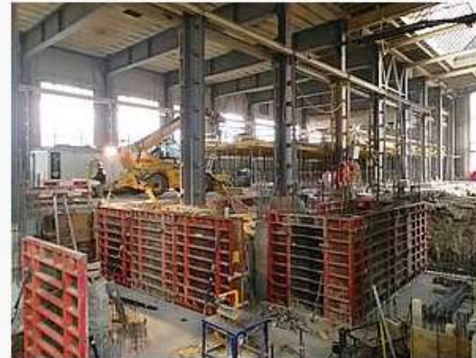
Der Bau der neuen ZHAW-Bibliothek in Winterthur (Halle 87).
