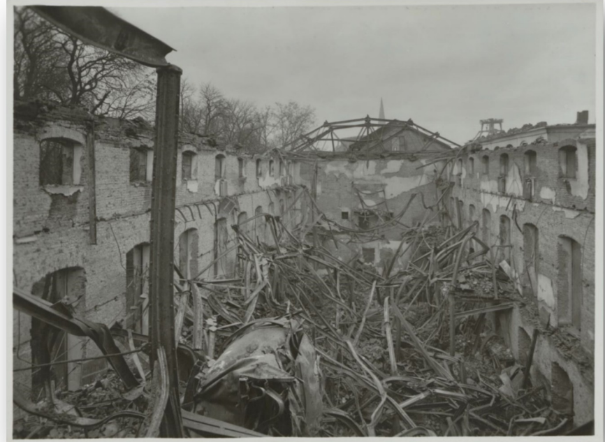
Die zerstörte Universitätsbibliothek im Galerietrakt des Universitätshauptgebäudes links des Koblenzer Tors, Frühjahr 1949. Fotograf: Alex Keller, Bonn. Universitäts- und Landesbibliothek Bonn.
