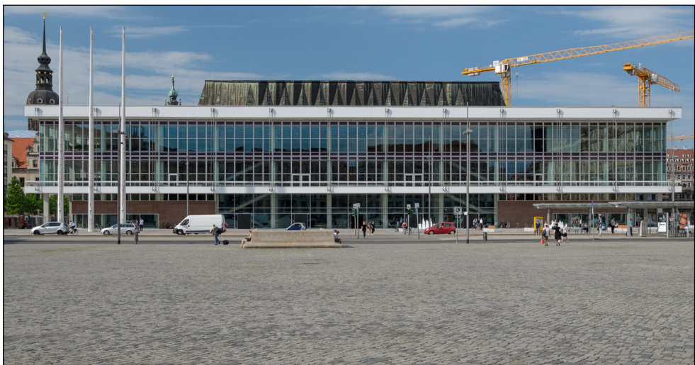
Abb. 1: Hauptfassade des Kulturpalastes Dresden, Blick vom Altmarkt aus, 2017. Foto: Städtische Bibliotheken Dresden/ Mario Gaitzsch
