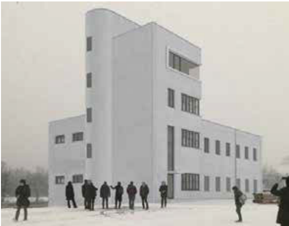
Abb. 1: Der Tower des ehemaligen Flugplatzes nach dem Umbau. © F. Nagler Architekten GmbH, München.
