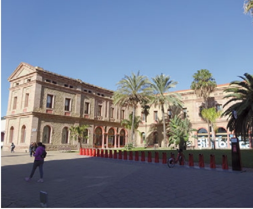
Fig. 11: Biblioteca Nou Barris/Nou Barris Library, Barcelona. Architects: Ricard Pèrdigo and Tomàs Rodríguez. © Santi Romero.
