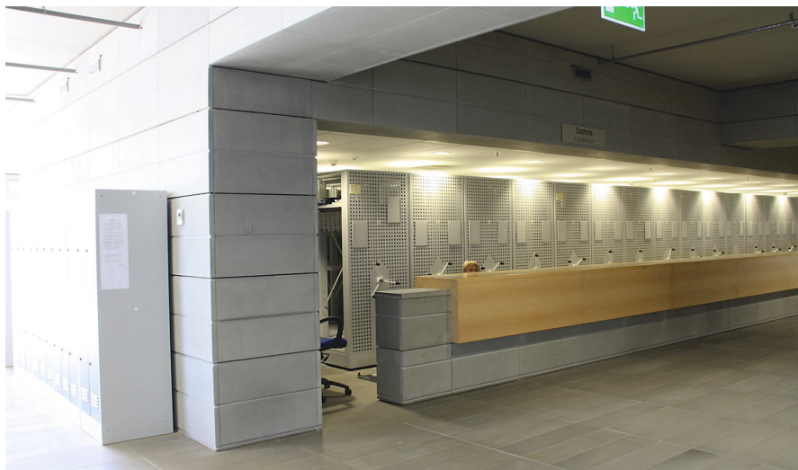
Hebeschubanlage als Garderobe.
