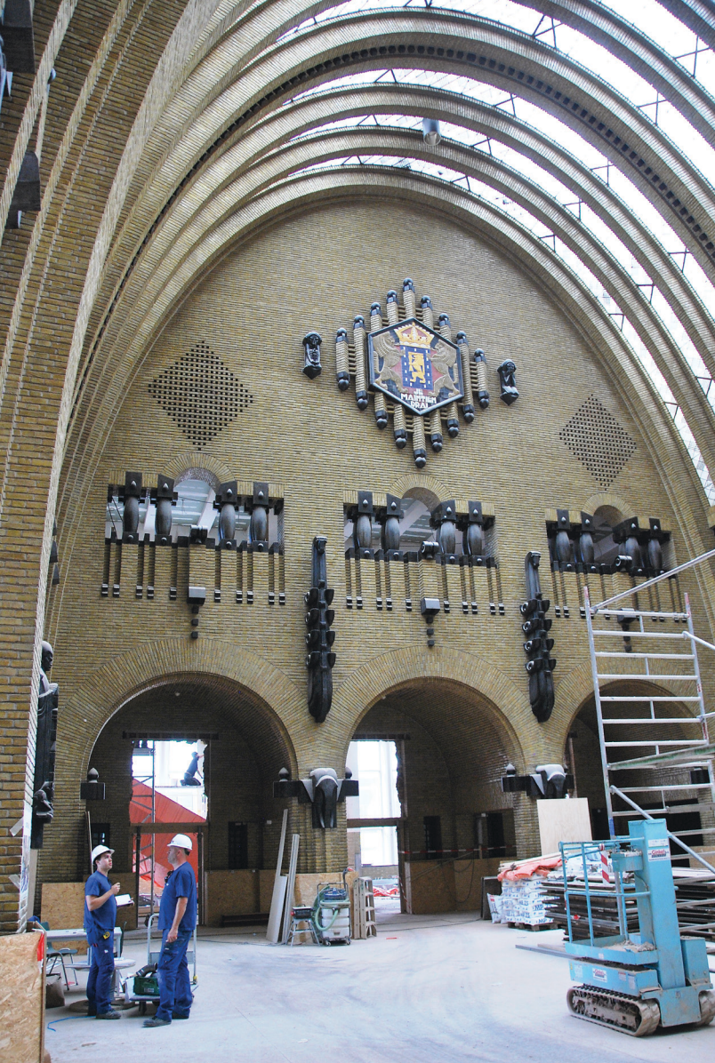
Die große Halle: Dieser imposanteste Teil des gesamten Gebäudes im Stil des Art Déco wirkt aufgrund der Höhe und der parabolartigen Rundbögen an der Decke wie eine Kathedrale. Foto: Barbian
