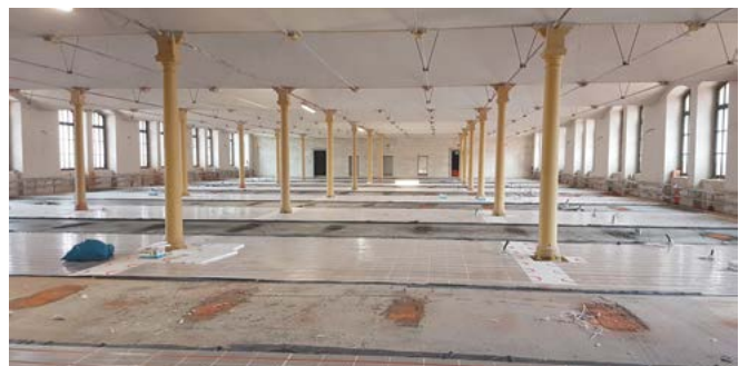
Gut zu erkennen ist die historische Ausstattung: Säulen, Gewölbedecke und Tragekonstruktion. Foto: TU Chemnitz/Steinebach.
