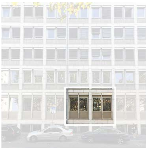
Bestandsfassade Hasengasse | Ausschnitt
