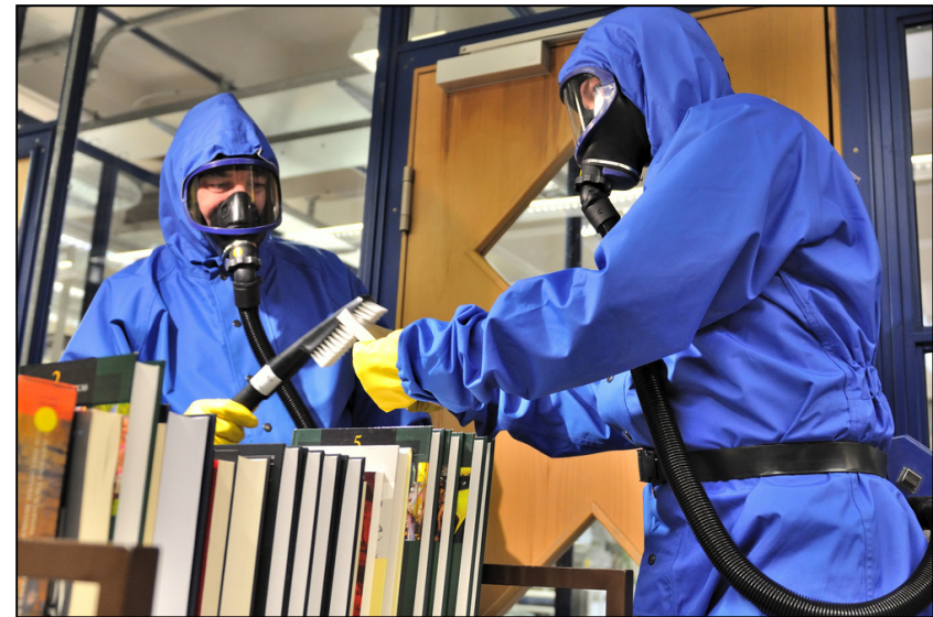
Reinigungsarbeiten wegen Asbest (Foto: Universität Konstanz)
