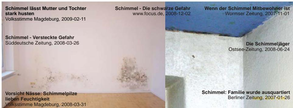
Abbildung 1.1: Zwei untersuchte Innenräume mit sichtbarem Schimmelpilzbefall und Schlagzeilen der Tagespresse.<sup>[7-13]</sup>
