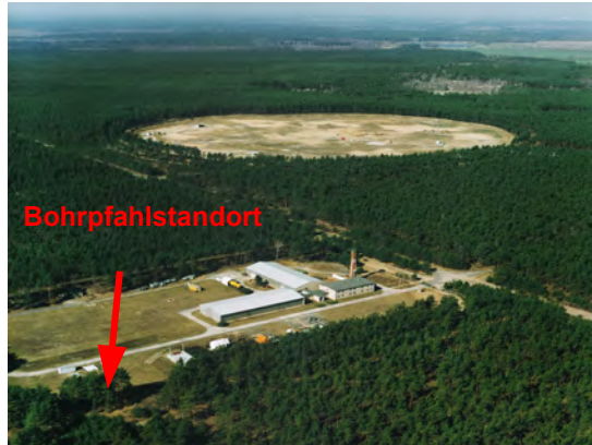
Abbildung D.2: BAM Testgelände Technische Sicherheit Horstwalde (TTS) (Luftbild: BAM, Aufnahme vor Herstellung Bohrpfähle)
