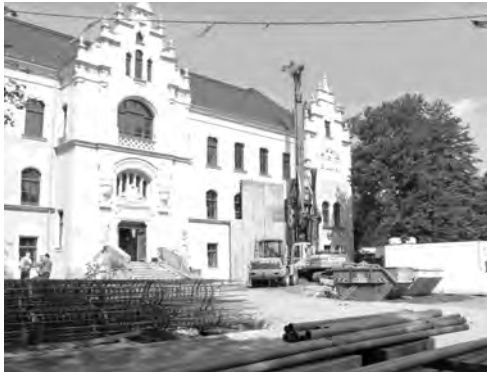
Abbildung E.10 (oben): Baustelle in Grimma.
