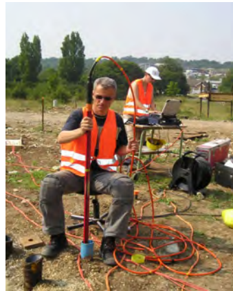
Abbildung 9.5: Oben: Bohrlochradareinsatz auf dem Testgelände des Building Research Establishment (BRE), bei Chattenden, Kent, UK. Links: Prinzip der Bohrlochradarmessung zur Pfahllängenermittlung.
