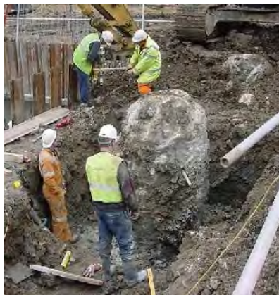
Abbildung 1.1: "Would you re-use this?": Freilegen eines Fundamentpfahles beim Gebäudeabriss. Foto: BRE, 2004.
