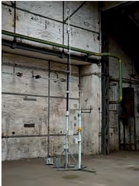
Abbildung 93: Ultraschallanemometer bei den Strömungsmessungen in 1 m, 2,7 m und 6 m Höhe in dem ehemaligen Kesselhaus der Werkshalle 21 in Wildau, Deutschland
