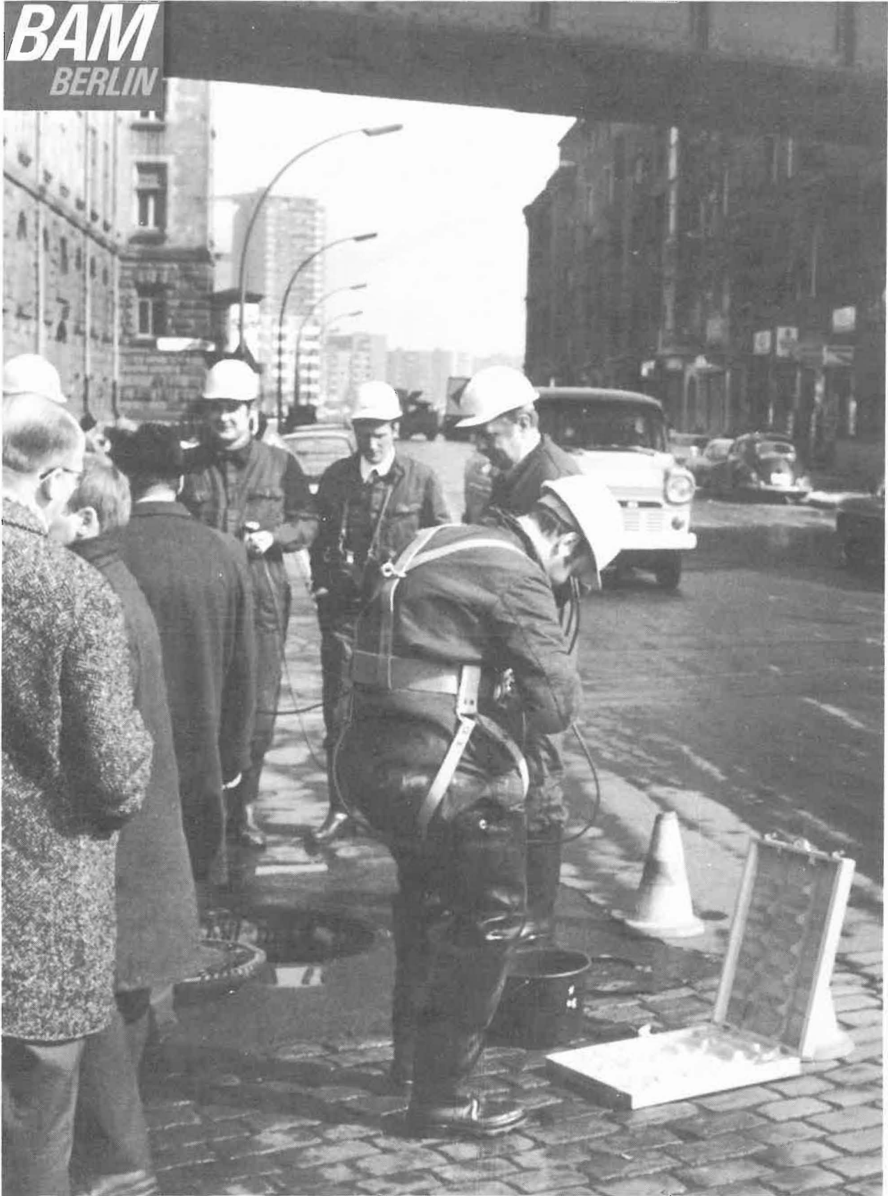
Vorbereitung des Einstiegs in das Berliner Ortsentwässerungsnetz zur Erprobung von Gasanalysenverfahren
