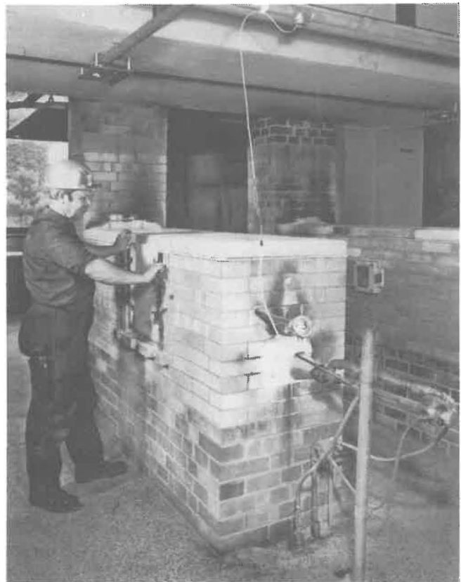
Bild 11 Kleinprüfstand nach DIN 18 082 Blatt 2, Bauart BAM
