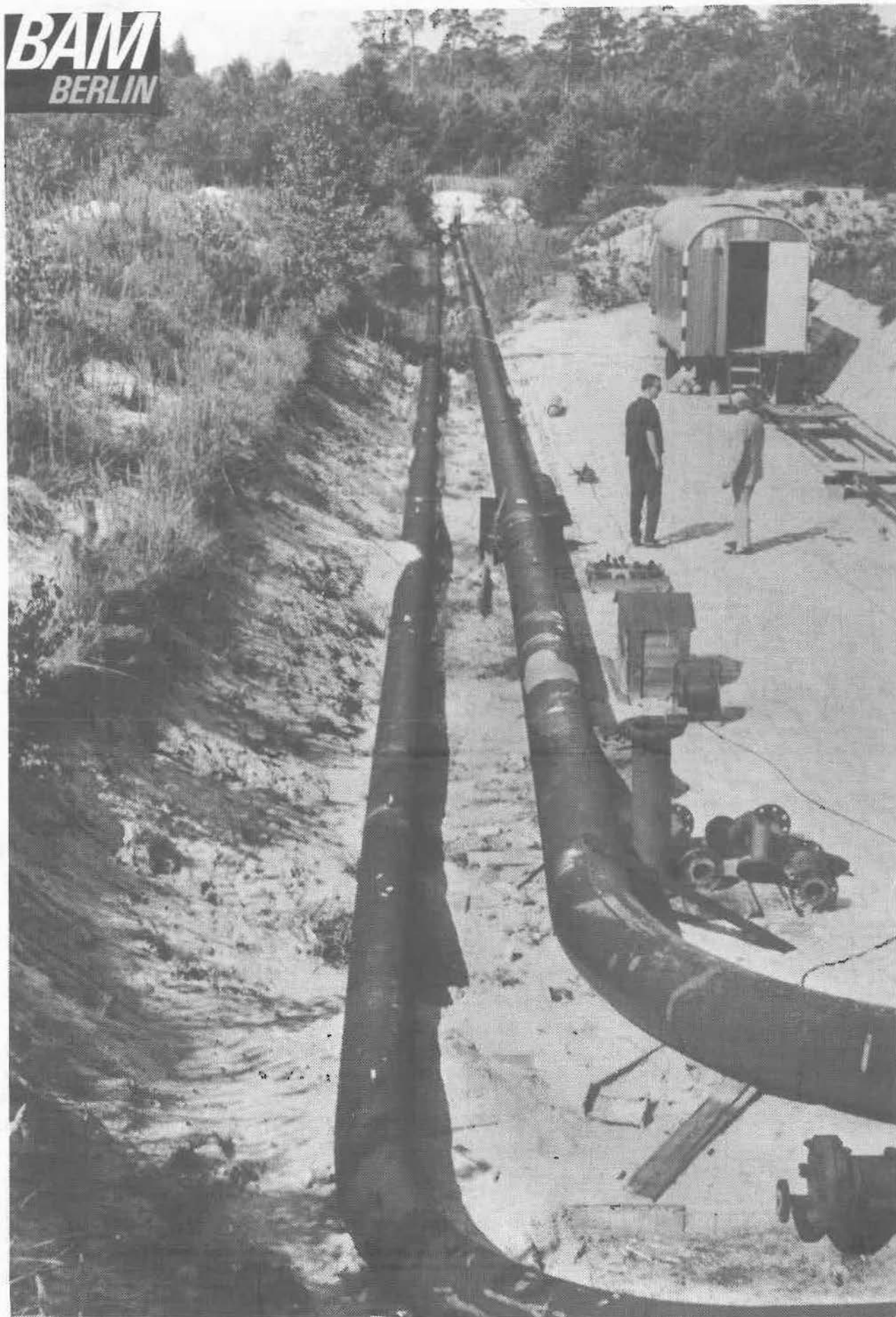
Rohrleitungsprüfstand der Bundesanstalt für Materialprüfung
