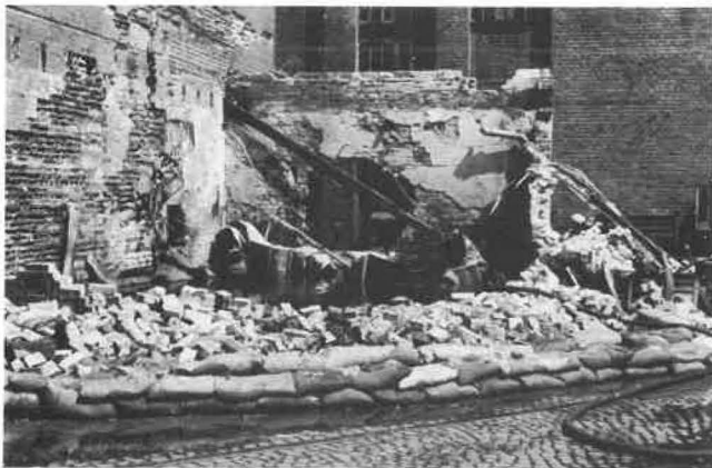
Bild 7 Schadensfall in einer Druckgasflaschen-Batterie-Anlage
