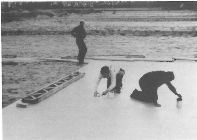
Abb. 3 Herstellung einer PVC-Basisabdichtung
