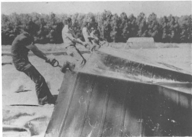
Abb. 4 Verlegung einer PE-Basisabdichtung
