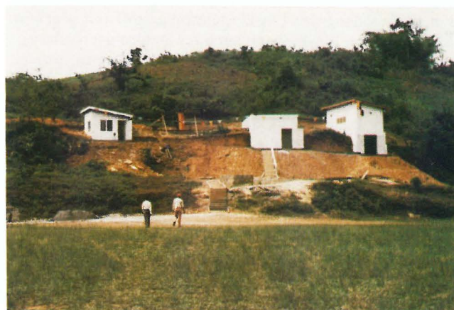
Abb. 4 Sprengstoffprüflabor bestehend aus: Meßraum, Sprengbunker und Pendelraum
