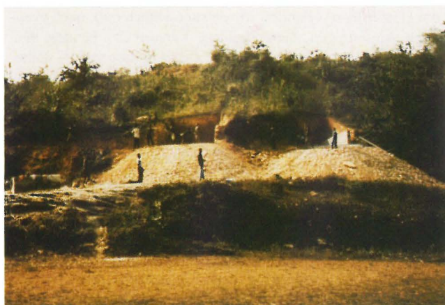
Abb. 2 Stand der Bauarbeiten Anfang April 1983
