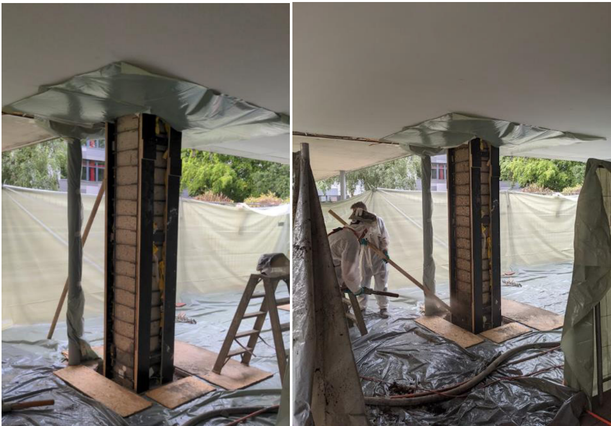
Abb. 85: Herstellung des Demonstrators, Stütze mit Schalung (links), Einspritzen der Anoden (rechts)
