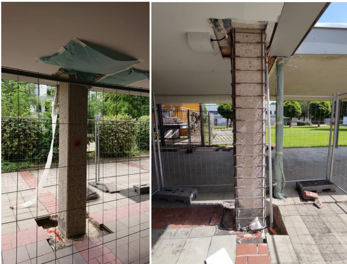
Abb. 83: Herstellung des Demonstrators, Stützen nach dem Sandstrahlen (links) und nach Anbringen von Umschnürungsbewehrung und Anodensystem (siehe dazu auch Abb. 87)
