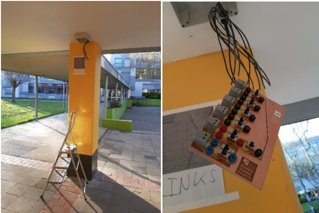
Abb. 87: Herstellung des Demonstrators, fertige Stütze (links), Installation der Messtechnik (rechts)
