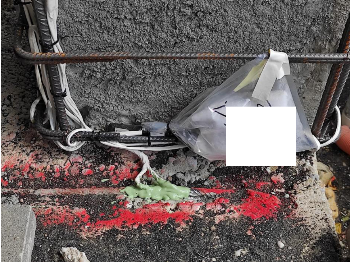
Abb. 84: Herstellung des Demonstrators, Anode im Plastikbeutel mit Referenzelektrode und Bewehrungsanschluss
