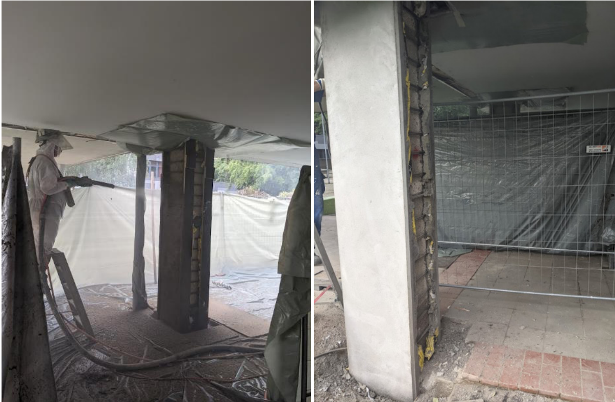
Abb. 86: Herstellung des Demonstrators, Spritzbetonauftrag (links), 2-seitig fertiggestellte Stütze (rechts)
