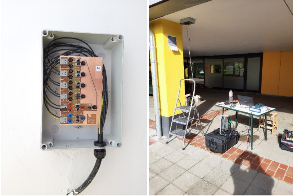
Abb. 88: Herstellung des Demonstrators, fertige Messtechnik (links), Durchführung 1. Messkampagne (rechts)
