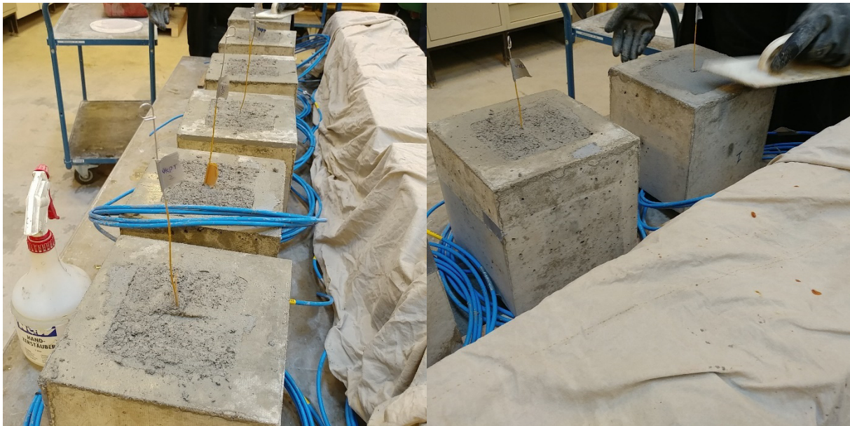
Abb. 39: Links im Ankoppelmörtel eingebettete auskragende Anschlüsse der Anodensysteme (A1 und A2) und rechts abziehen und glätten der Ankoppelmörteloberfläche
