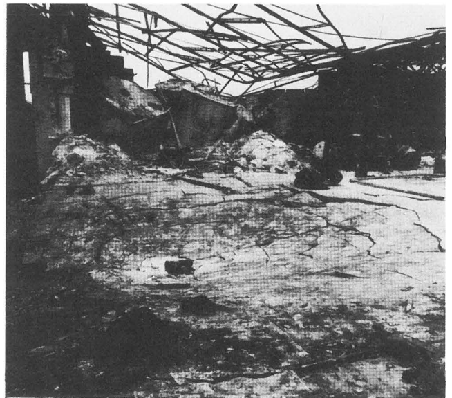
Abb. 7 Brand- und Explosionsunglück B & R Hauliers, Salford am 25. 9. 1982; Vertiefung im Hallenboden an der Stelle der Chlorat- lagerung.
