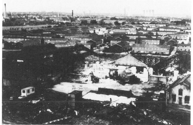
Abb. 6 Brand- und Explosionsunglück B & R Hauliers, Salford am 25. 9. 1982; Schadensstelle
