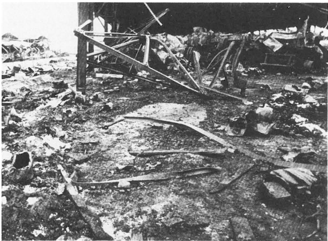
Abb. 4 Brand- und Explosionsunglück Braehead Container Depot, Renfrew am 4. 1. 1977; Inneres der zerstörten Lagerhalle
