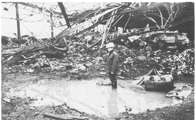
Abb. 5 Brand- und Explosionsunglück Braehead Container Depot, Renfrew am 4. 1. 1977; „Krater“ an der Explosionsstelle
