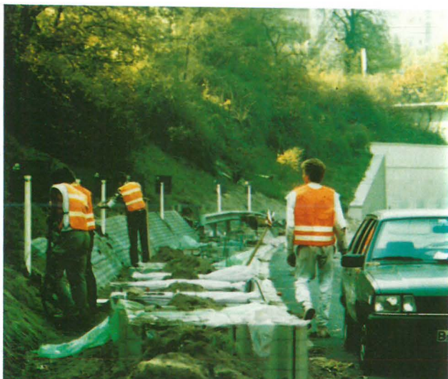
Abb. 5 Warnwesteneinsatz auf einer Baustelle der Stadtautobahn in Berlin
