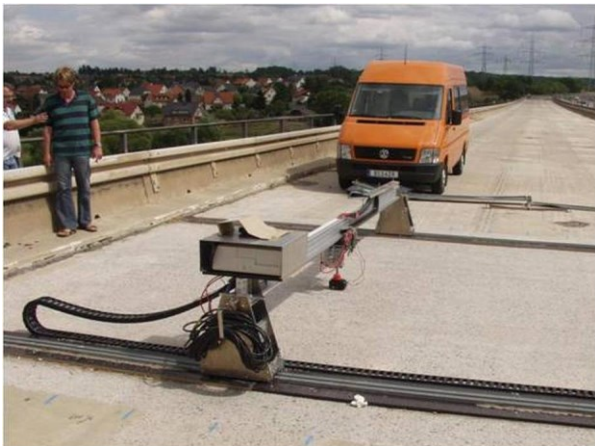
Abbildung 12 Bauwerkscanner für die Untersuchung einer Fahrbahnplatte
