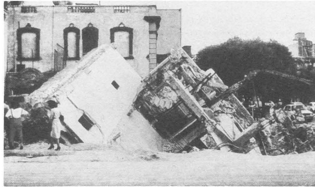
Abb. 4 Durch Bodenverflüssigung (Liquefaction) umgesunkenes Gebäude nach dem Erdbeben in Mexiko 1985 (Ammann, W., 1986)
