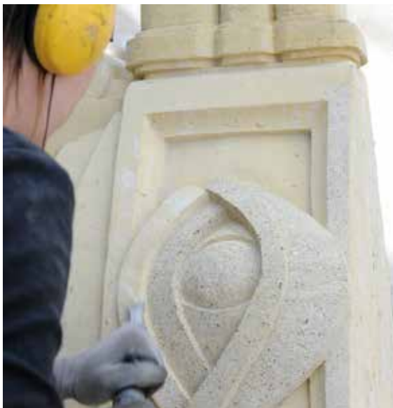
Abb. 7: Einsatz von Steinmetztechniken: Spitzen, Bossieren, Scharrieren, Schleifen zur Erzielung der Natursteinanmutung.
