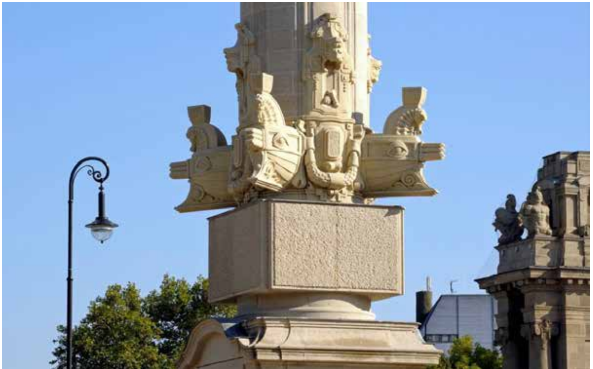
Abb. 9: Fertiggestelltes Ensemble der Kandelaber des Charlottenburger Tors im Jahr 2009 aus steinmetztechnisch bearbeitetem Bildhauerbeton in direkter Verbindung mit Ettringer Tuffstein.
