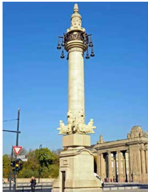
Abb. 10: Fertiggestellter Kandelaber des Charlottenburger Tors im Jahr 2010 - Bildhauerbeton in direkter Verbindung mit Ettringer Tuffstein.
