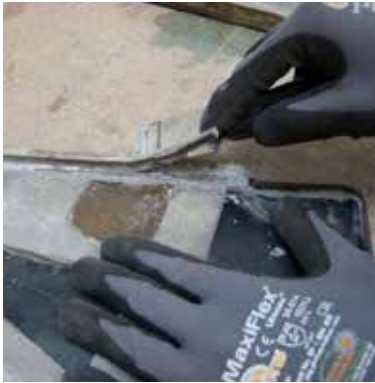
Abb. 8b: Entfernen des asbesthaltigen Kitts mit einem Spachtel und einer Drahtbürste. Anschließendes Spülen mit Wasser. Risse an der Innen- und Außenseite des Betons werden mit einem Trennschleifer geöffnet. Risse am Rand der Elemente werden ebenfalls mit einem Trennschleifer geöffnet und bearbeitet.
