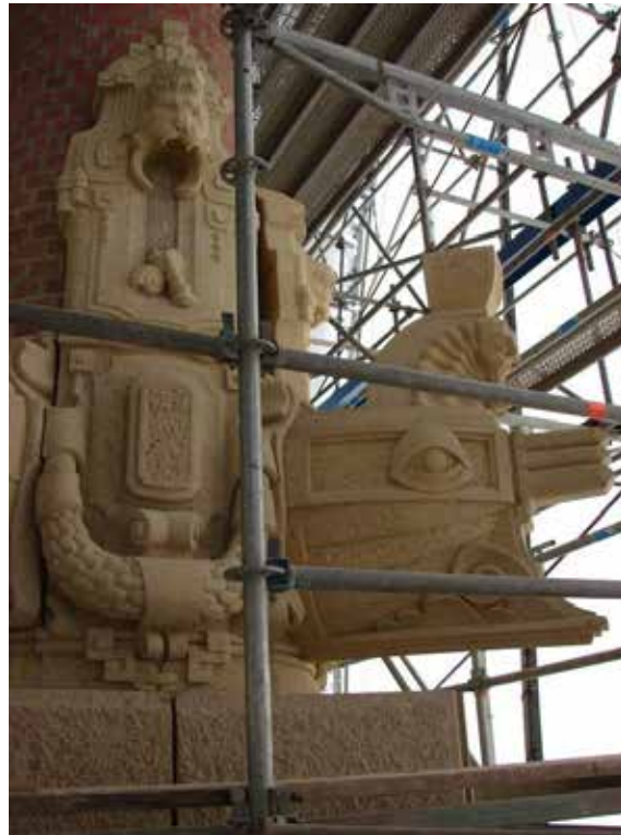
Abb. 8: Zusammenfügen der Einzelemente Laterne, Seepferdchenkopf und Galeerenrumpf und anschließende Montage auf dem Postament mit rückwärtiger Verankerung im Mauerwerk über Gewindeanker.
