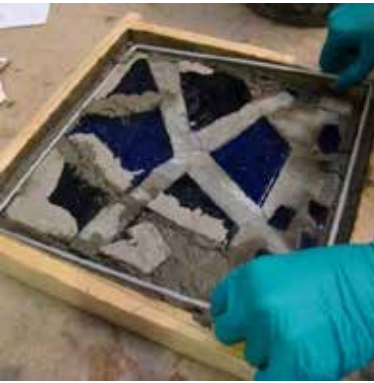
Abb. 8e: Die Farbe des Mörtels wird auf die Farbe des Betons der Innenseite angepasst. Für die Instandsetzung geschädigter Randbereiche wird eine passende Holzschalung der Fensterelemente angefertigt. Höhenunterschiede im Bereich der Dickgläser werden mit Ton ausgeglichen. Im Anschluss daran erfolgt die Reprofilierung mit einem Reprofilierungsmörtel. Nach dem Aushärten wird die Holzschalung entfernt, die äußere Oberfläche kann mit einer Stahlbürste nachbearbeitet werden, um das optische Erscheinungsbild einer verwitterten Betonoberfläche zu erzielen.
