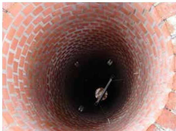
Abb. 4: Bauzeitlicher Einblick in den begehbaren Kandelaber aus Mauerwerk.
