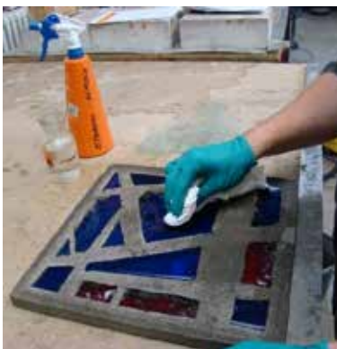
Abb. 8c: Die Dickgläser werden mit Stahlwolle und einem Wasser-Ethanol Gemisch (Mischungsverhältnis 1:1) gereinigt. Kleinere Risse und Abplatzungen der Gläser werden mit einem UV-Kleber repariert. Die Gläser werden beidseitig mit passenden Schutzfolien beklebt, um sie während des Sandstrahlens vor Beschädigungen zu schützen.
