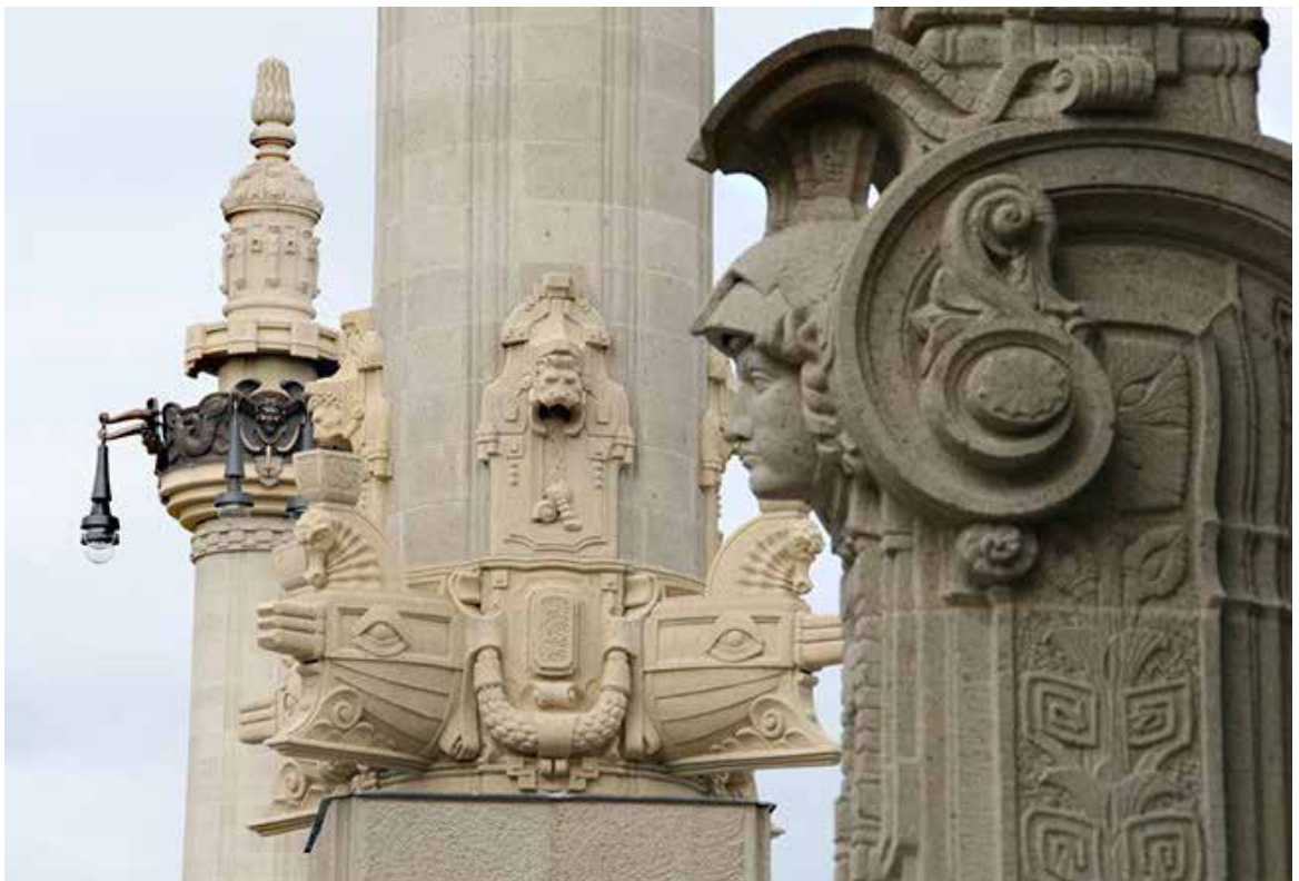
Abb. 2: Details der Kandelaber an Charlottenburger Tor und Anläufer der Charlottenburger Brücke, Quelle: Opus Denkmalpflege GmbH 1 .
