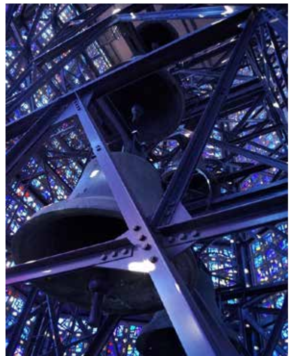
Abb. 5: Innenansicht des Glockenturms.
