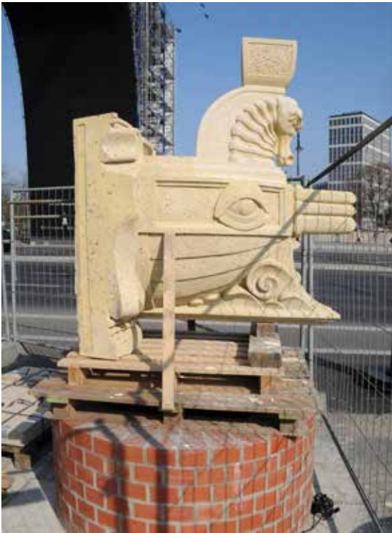
Abb. 8: Zusammenfügen der Einzelemente Laterne, Seepferdchenkopf und Galeerenrumpf und anschließende Montage auf dem Postament mit rückwärtiger Verankerung im Mauerwerk über Gewindeanker.
