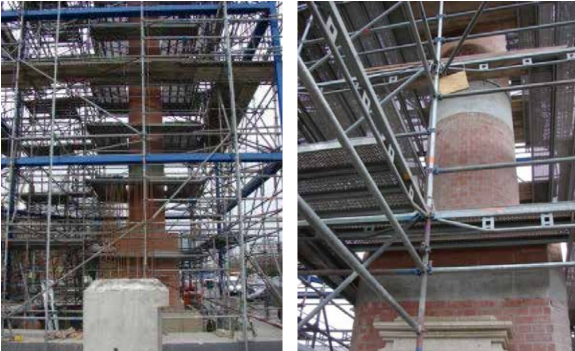
Abb. 3: Massivbauweise in Stahlbeton und bewehrtem Mauerwerk der inneren Schale der Kandelaber.
