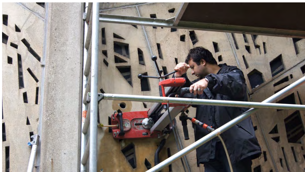
Stephanuskirche Buer in Gelsenkirchen – Probeentnahme durch Kernbohrung zur Zustandserfassung von „Dalle de verre“ Betonfenstern Stephanus Church Buer in Gelsenkirchen – Sample taking by core hole drilling for condition survey “Dalle de Verre” Concrete windows
