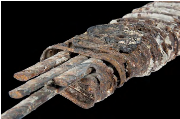
Beschädigte Spannstähle aus der Berliner Kongresshalle Damaged steel tension members from the Berlin Congress Hall
