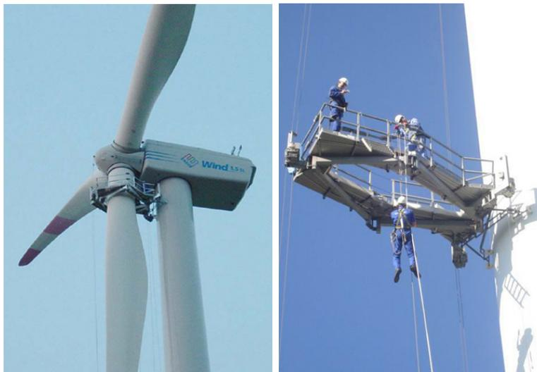
**Abbildung 1.4:** Rotorblatt-Inspektion mit seilgestützter, selbstkletternder Arbeitsbühne der Fa. Aeroconcept
