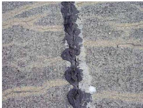
Schäden an Fugenfüllsystemen in Verkehrsflächen infolge überlagerter mechanischer und klimatischer Beanspruchung (Alterungsbeanspruchung)
