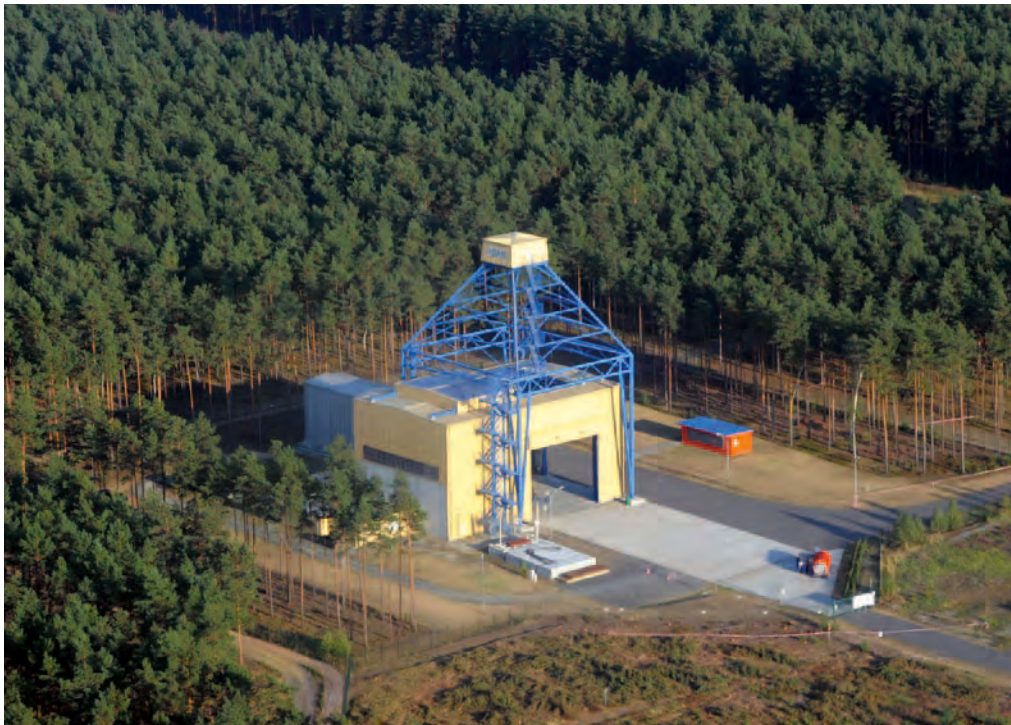
Die große Fallversuchsanlage auf dem BAM Testgelände Technische Sicherheit
