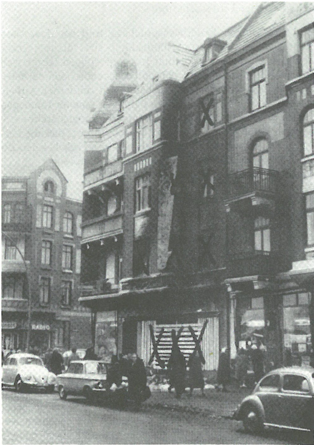
Bild 1 Brandübertragung über eine Außenwand vom Erdgeschoß bis ins 3. Obergeschoß beim Brand eines Ladengeschäftes (nach Schütze [6], dort Bild 7)
