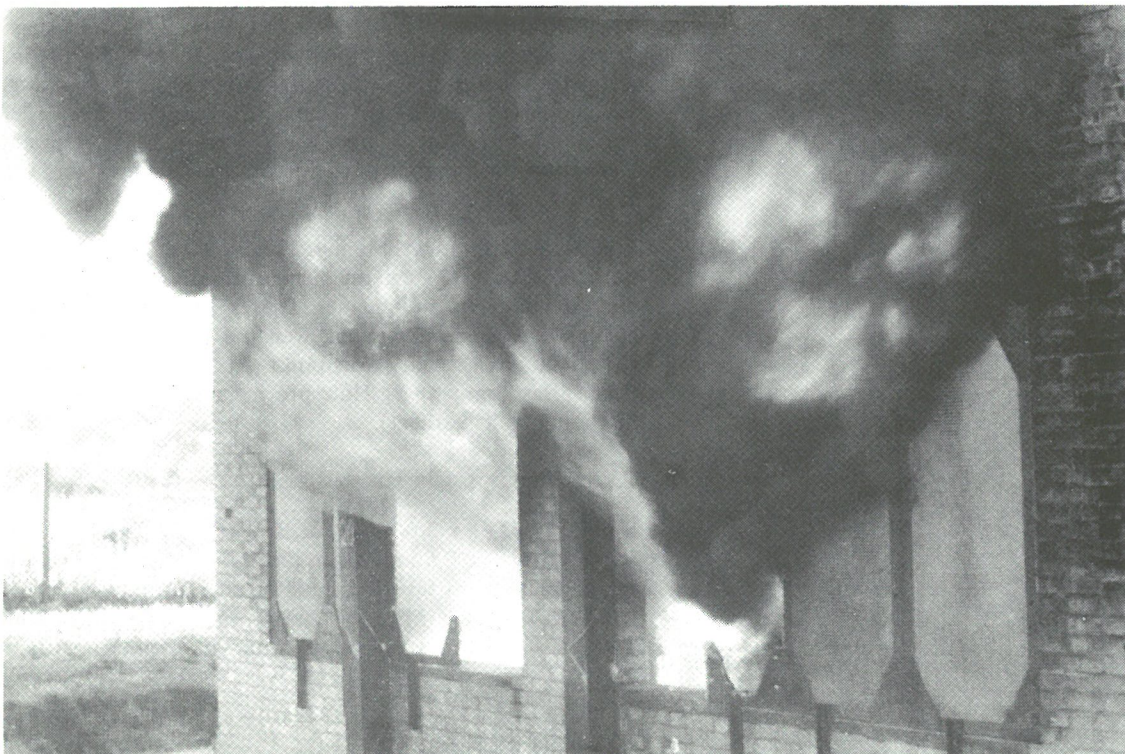
Bild 6 Versuchsbrandhaus Boreham Wood, England, während eines Brandversuches mit einer Brandbelastung von 30 kg Holz/m 2 und „1/4 ventilation“ nach [11], dort Plate 3 (b)
