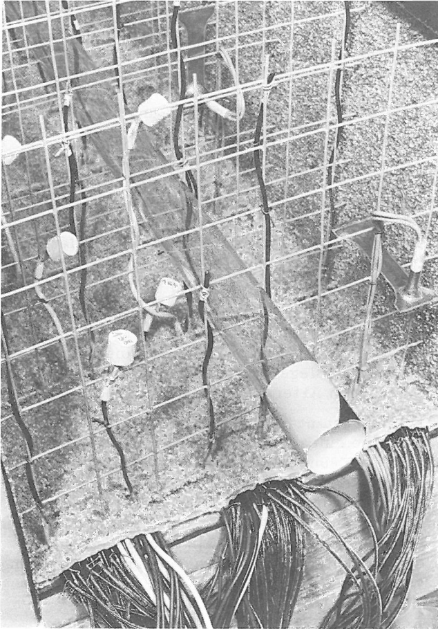
Bild 8 Ansicht eines Ausschnittes der Meßebene Q vor dem Betonieren mit Dampfsperre an den Außenseiten, Drahtgitter und daran befestigten Thermoelementen, Feuchtigkeitsmeßelementen und Dehnungsmeßelementen
