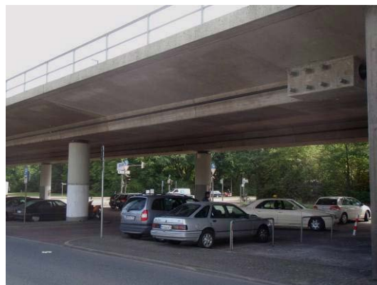
Abbildung 12: Externes Längsspannglied mit Ankerblock
