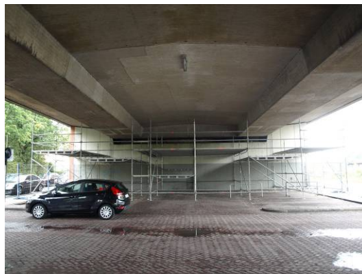
Abbildung 2: Unteransicht des Bauwerkes BW165
