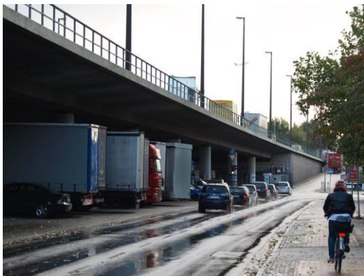
Abbildung 1: Seitenansicht des Bauwerkes BW165
