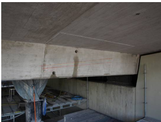
Abbildung 11: Seitenansicht Plattenbalken mit Kernbohrungen und eingezeichneten Spanngliedern und Position des Ankerblocks
