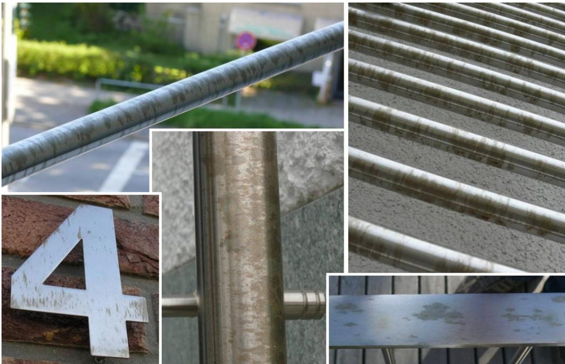
Abb. 1. Beispiele von Verfleckungen auf nichtrostenden Stahlkonstruktionen
