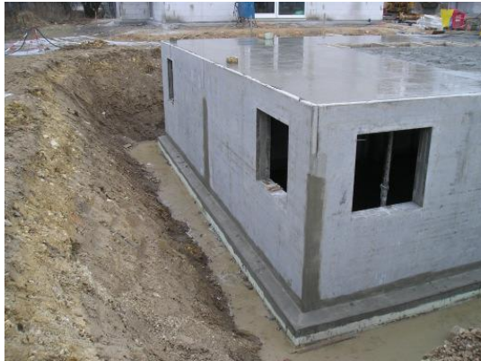
Abbildung 1: Rohbau des WU-Bauwerkes ausgeführt als Elementwandkonstruktion [18]
