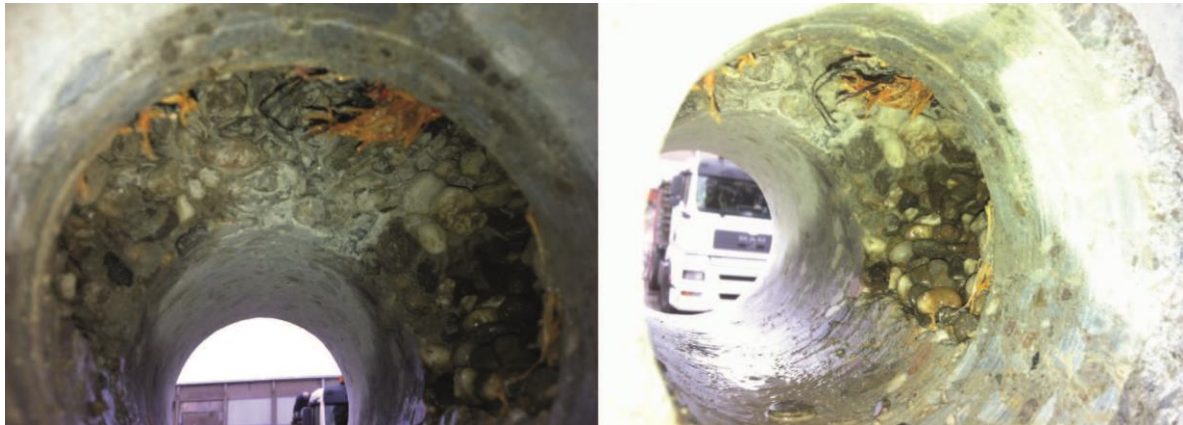
Abbildung 30: Überprüfung der Lage des Kiesnestes
