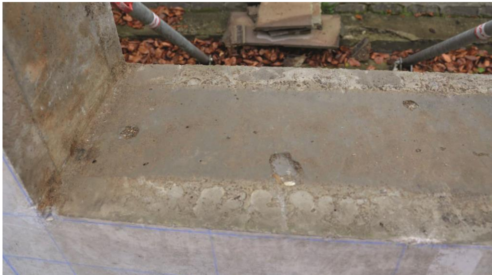
Abbildung 23: Fensterbereich nach der Betonage
