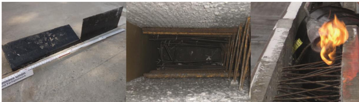
Abbildung 22: Beschichtetes Fugenblech, zusätzliche Bewehrung und thermische Austrocknung in Wand C
