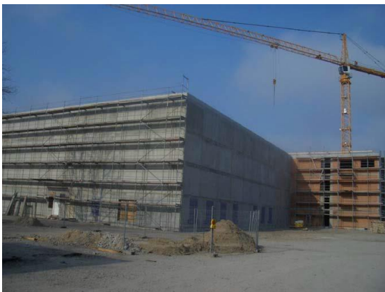
Abbildung 6: Außenansicht des Magazingebäudes
