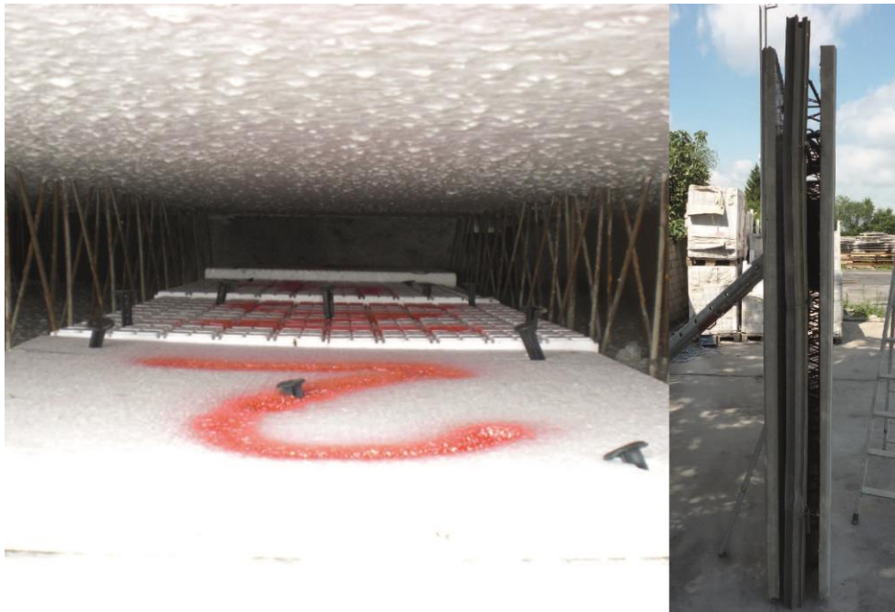
Abbildung 19: Polystyrol-Hartschaum in Wand A und Schwindrohr im Übergang Wand A zu Wand B
