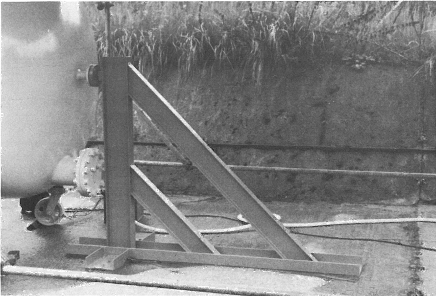
Bild 7 Widerlager aus U-Profil-Stahl
