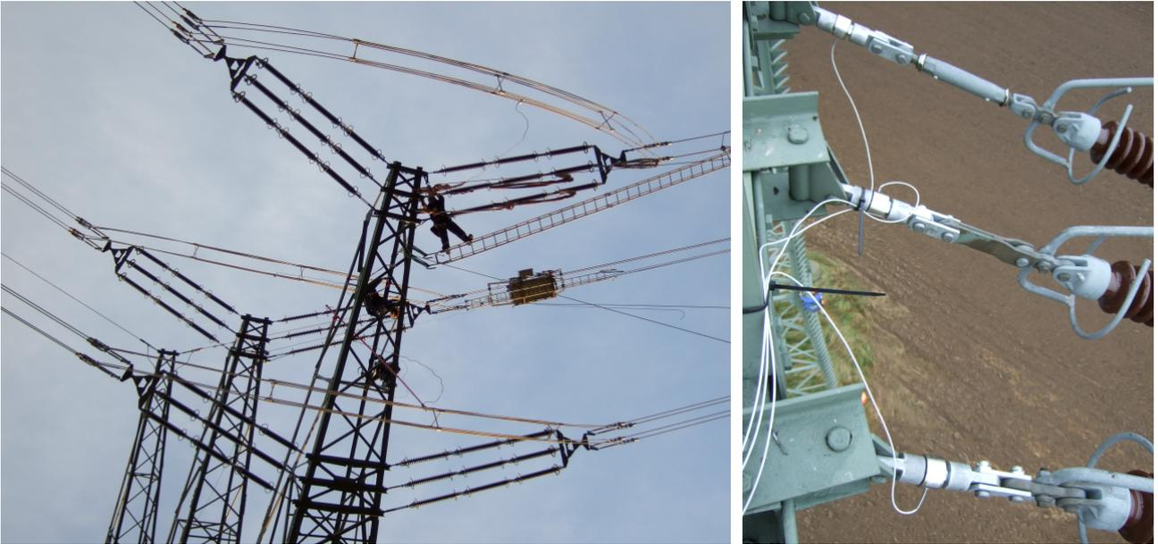
**Abbildung B.5:** Einbau und Detailansicht der eingebauten Kraftmessdosen am Abspannmast
