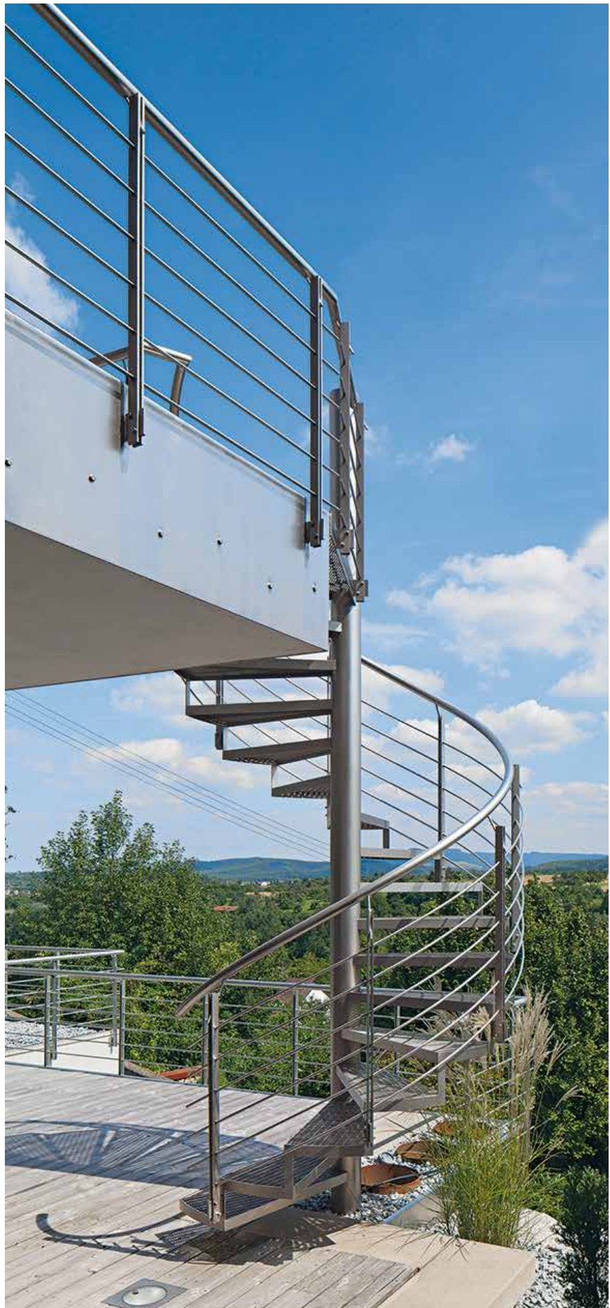
Bild 1: Korrosionsbeständig und verschleißfest ermöglichen nichtrostende Stähle langlebige und wartungsarme Konstruktionen unter atmosphärischen Bedingungen (Foto: MetallArt Metallbau Schmid GmbH, Salach)
