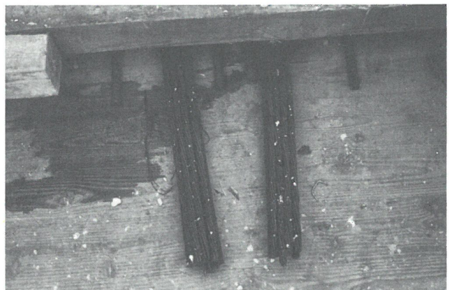
Abb. 32 Freiliegende Koppelstellen
