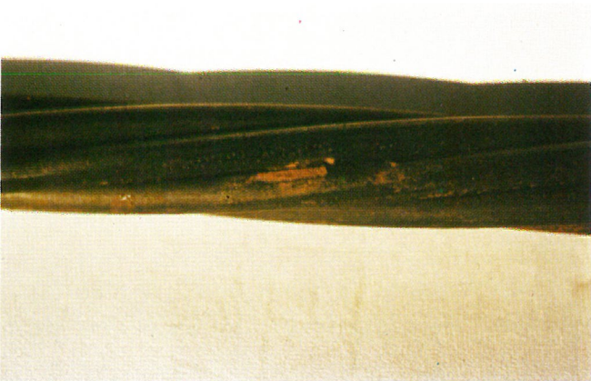
Abb. 21 Korrosion im Zwickelbereich von Litzen
