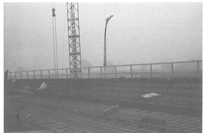
Abb. 26 Transport von Spanngliedern ohne Traverse
