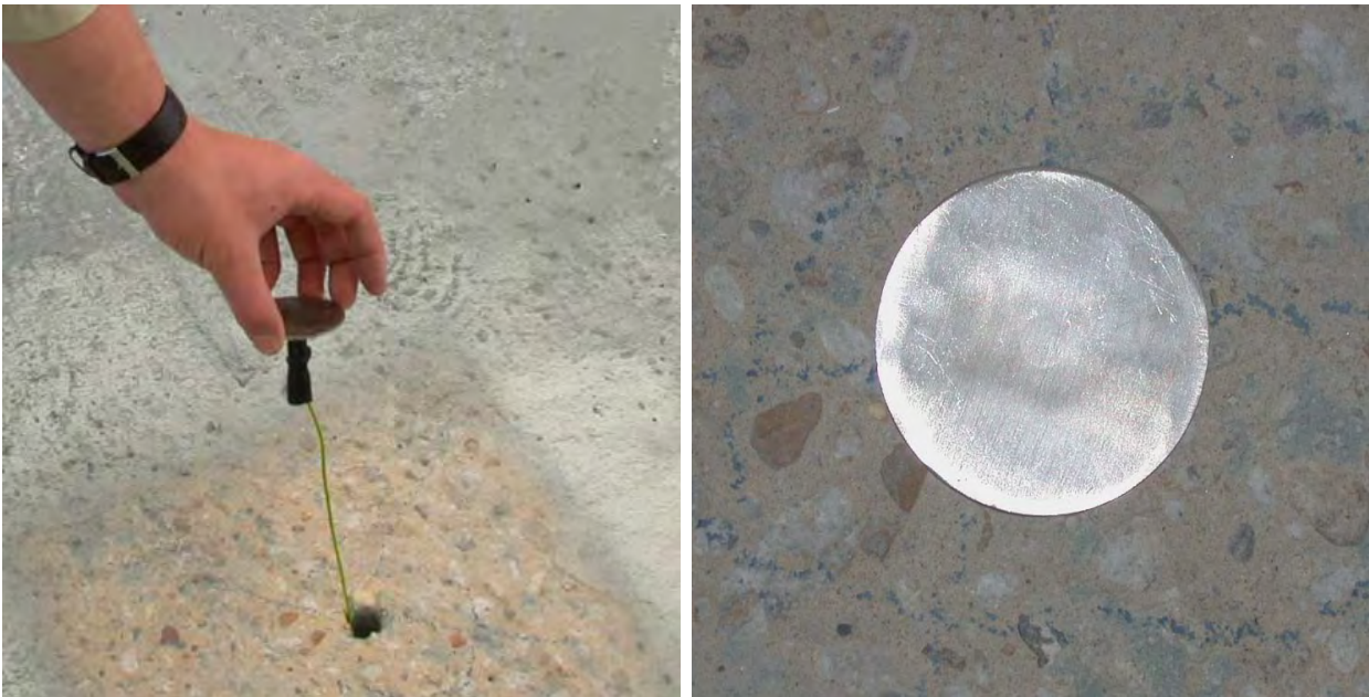
Bild 4.5-8: Anschlussplatten zur Herstellung der elektrischen Verbindung zur Zinkschicht
