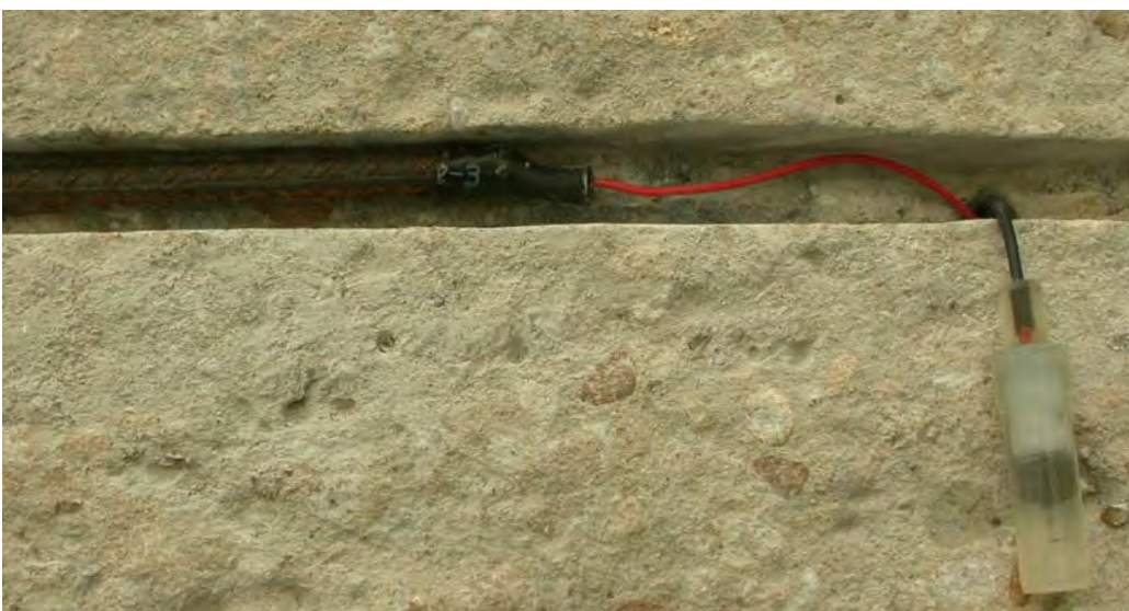
Bild 4.5-4: Zusätzlich eingebetteter Bewehrungsstab und zugehörige Referenzelektrode (noch mit Schutzkappe) vor dem Einbetten in chloridhaltigen Mörtel
