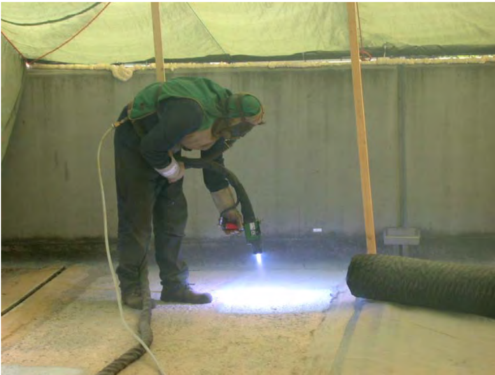
Bild 4.5-7: Auftrag der Spritzzinkschicht
