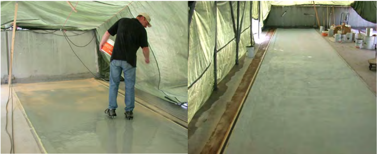
Bild 4.5-9: links: Abstreifung der Verschleißschicht vor Auftrag der Deckversiegelung rechts: abgeschlossene Installation.
