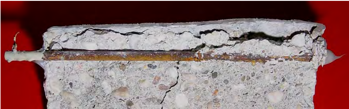
Bild 4.3-19: Ausbau von Bewehrungsstäben, Probekörper 124 3/10/4%/OS
