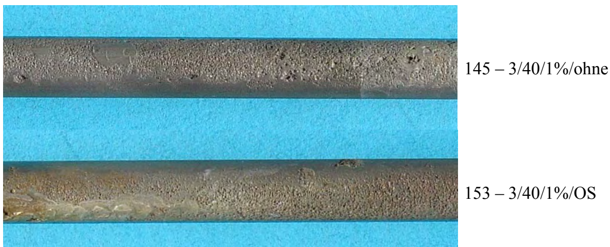
Bild 4.3-22: Erscheinungsbild der ausgebauten Bewehrung nach dem Beizen
