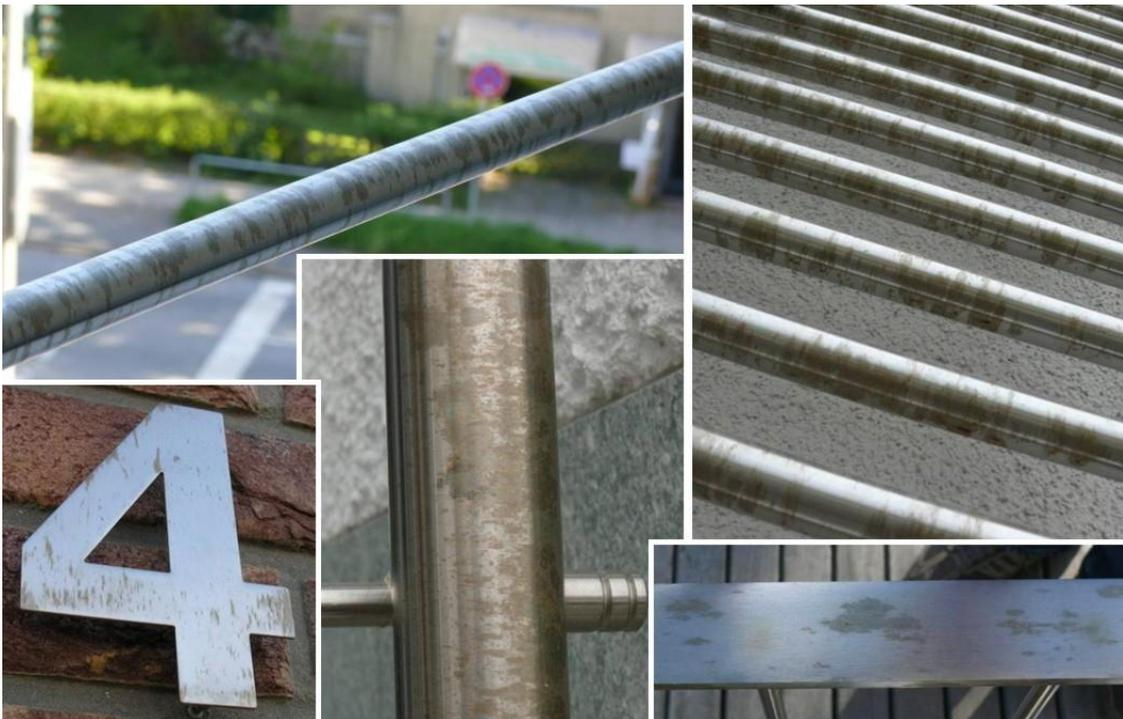
**Abb. 1.** Beispiele von Verfleckungen auf nichtrostenden Stahlkonstruktionen
