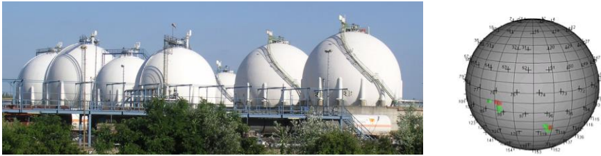
Abb. 1-2: Kugelgasbehälter in Karlsruhe (links, Bild: ikar.us) und 3D-Lokalisierung mit Sensorpositionen und SE-Indikationen (rechts, Bild: pirisndt.ca)
